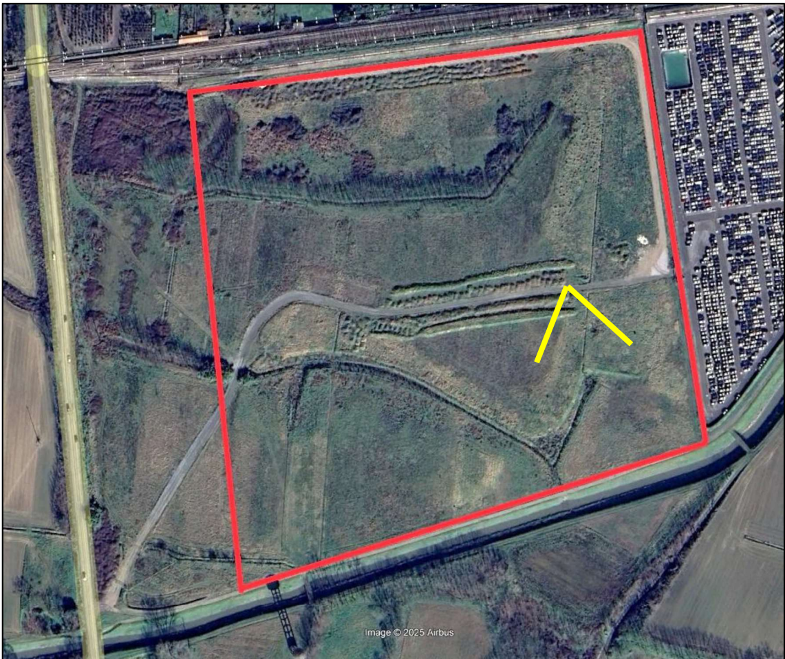
Visione sul fronte Sud-Est dell'area di intervento con presenza di vegetazione erbacea infestante.
