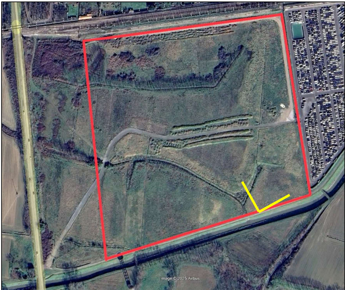
Visione sull'angolo Nord-Est dell'area di intervento in zona di contatto con l'ultimo ampliamento
