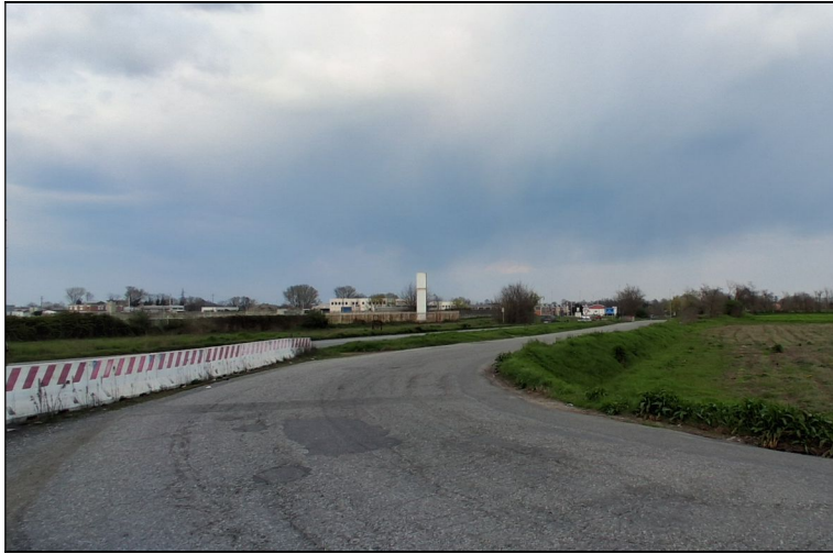
Figura 20. Strada "di arroccamento" di accesso alla logistica
