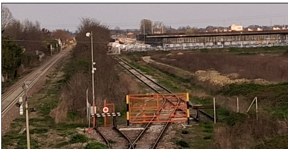
Figura 40. Vista delle aree dal cavalcavia ferroviario lungo la Strada Provinciale n. 193
