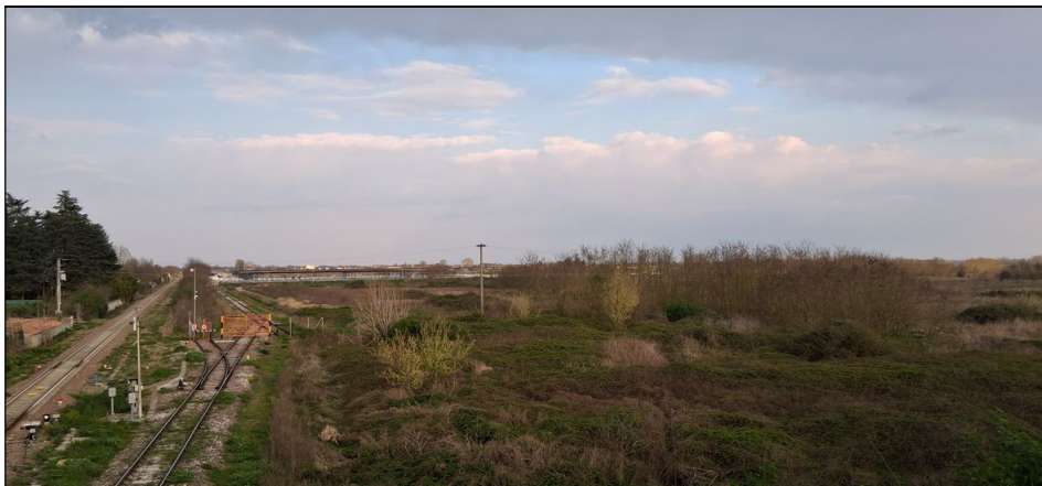
Figura 39. Vista delle aree dal cavalcavia ferroviario lungo la Strada Provinciale n. 193
