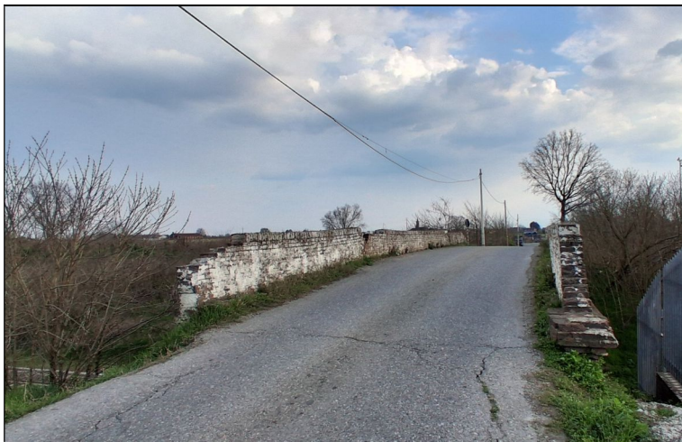
Figura 21. Ponte in mattoni sopra la ferrovia Pavia-Cremona
