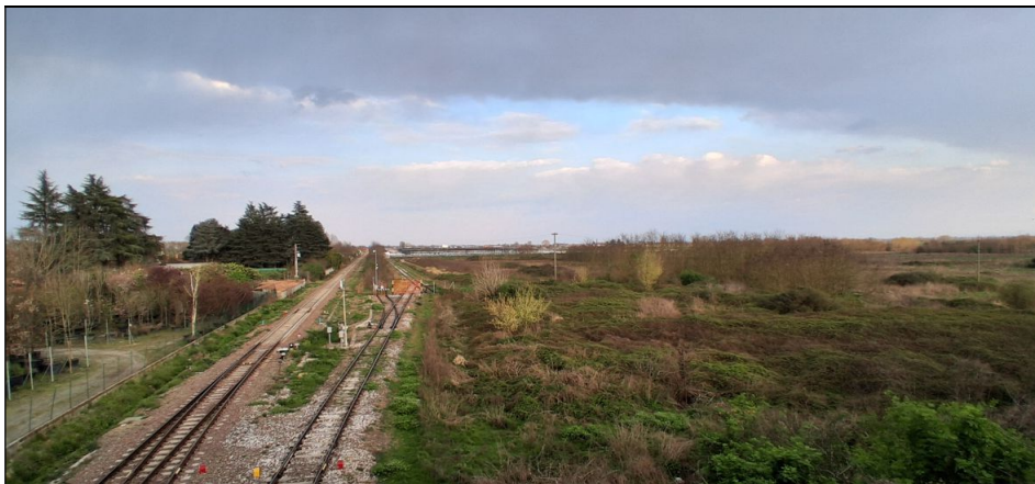
Figura 36. Vista delle aree dal cavalcavia ferroviario lungo la Strada Provinciale n. 193
