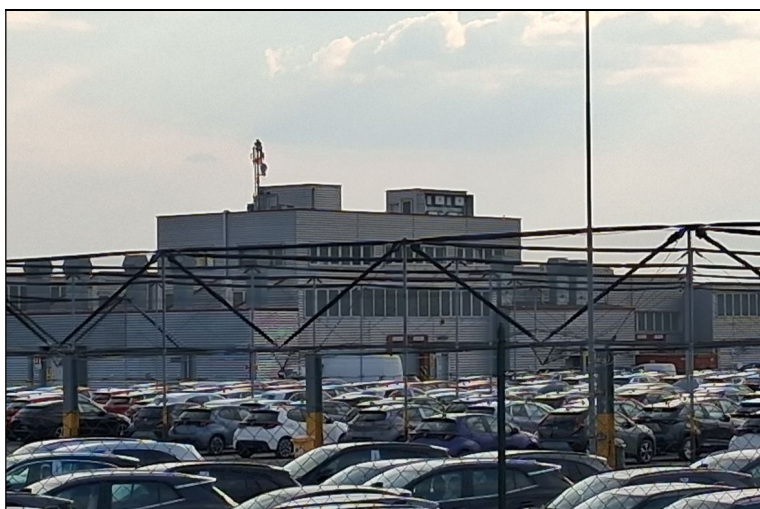
Figura 16. Logistica esistente: edificio adibito a officina, magazzini e uffici
