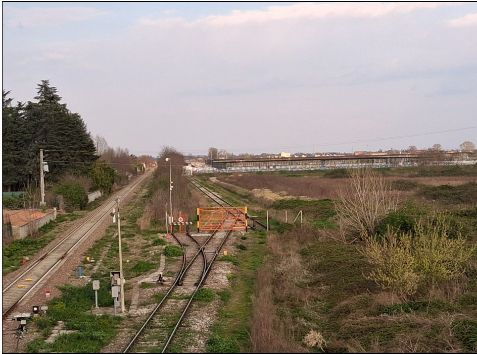
Figura 38. Vista delle aree dal cavalcavia ferroviario lungo la Strada Provinciale n. 193
