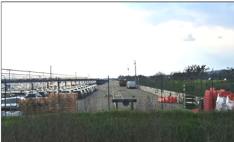
Figura 13. Logistica esistente: piazzale e raccordo ferroviario interno
