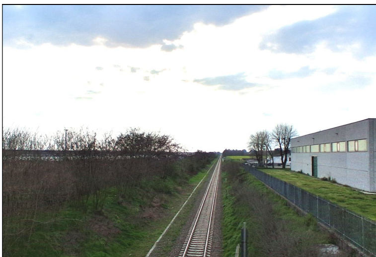
Figura 22. Ferrovia Pavia-Cremona: vista dal ponte della foto precedente
