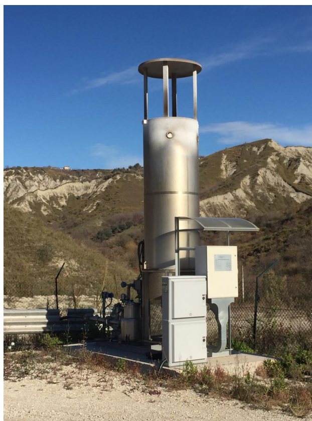
Figura 10 – Foto n. 10 – Torcia di emergenza
