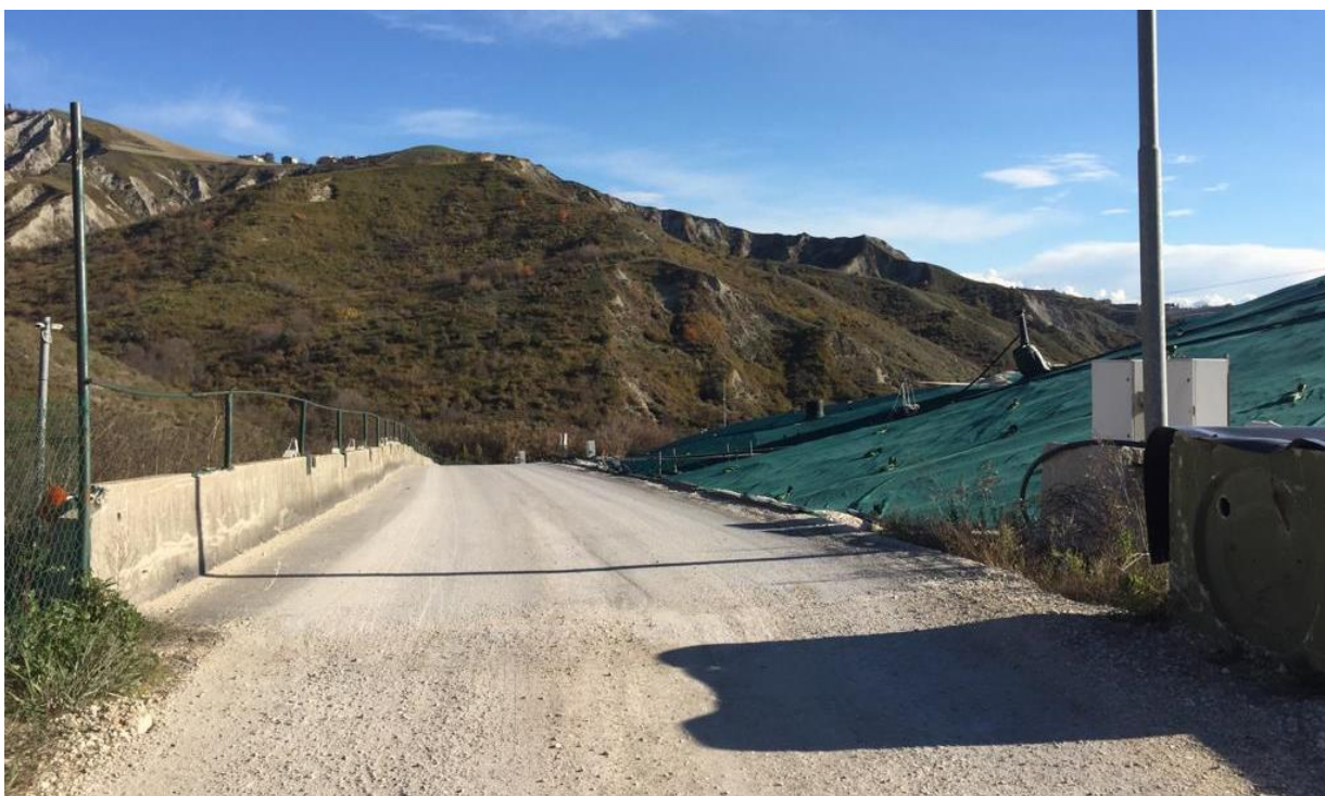
Figura 4 – Foto n. 4 – Argine in terre rinforzate già realizzato
