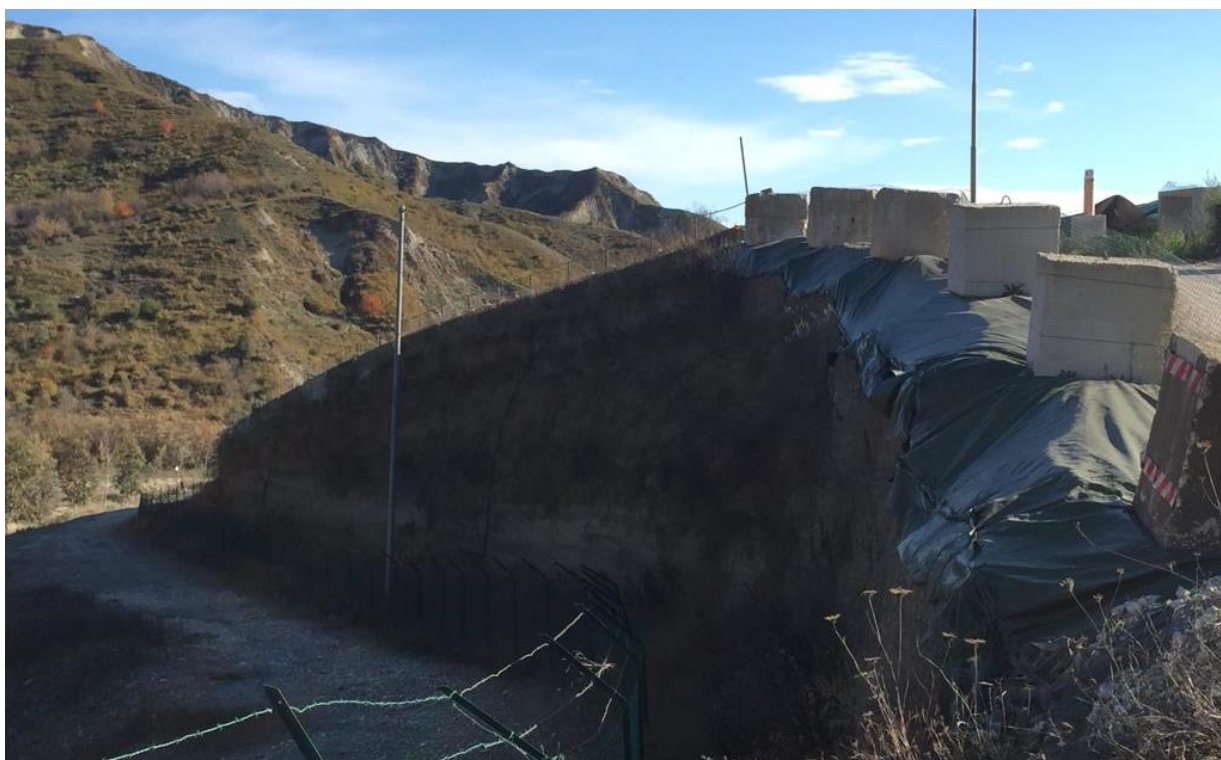
Figura 2 – Foto n. 2 – Vista laterale dell'argine in terre rinforzate già realizzato
