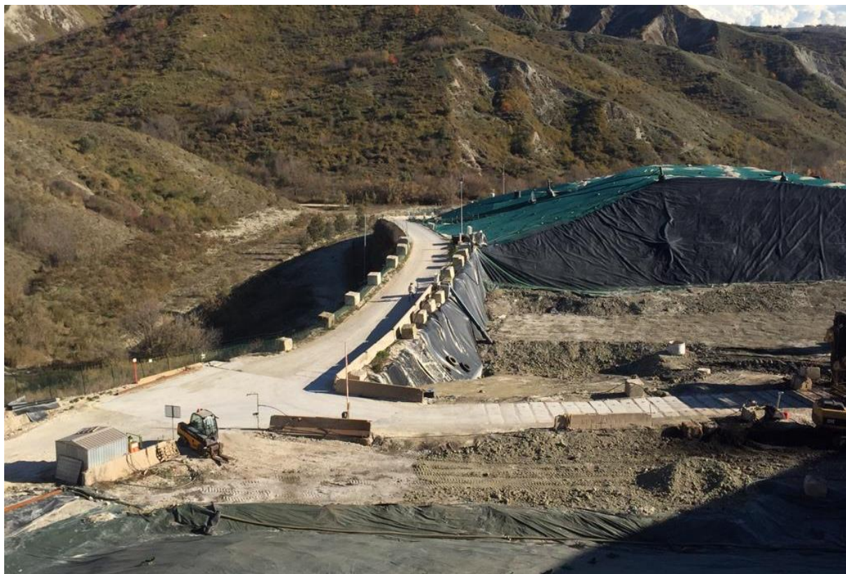
Figura 12 – Foto n. 12 – Vista dall'alto discarica 3 e argine perimetrale
