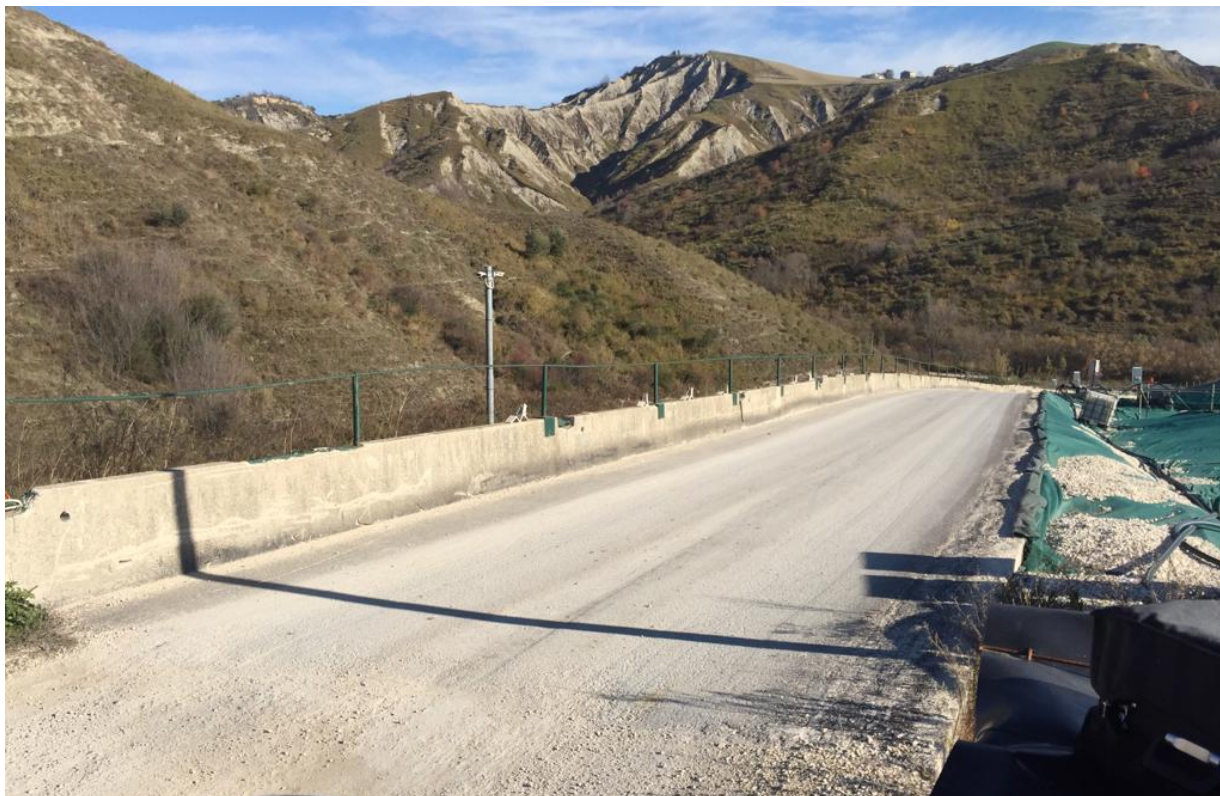
Figura 3 – Foto n. 3 – Argine in terre rinforzate già realizzato
