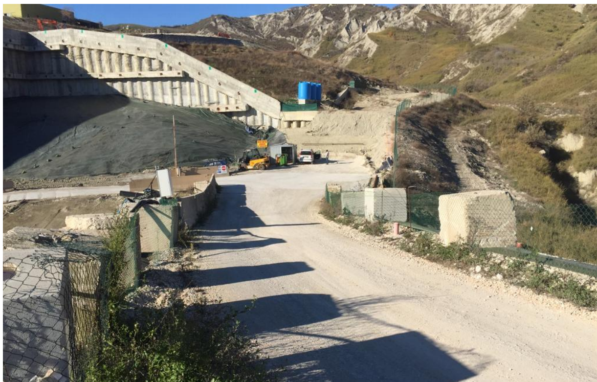
Figura 1 – Foto n. 1 – Argine perimetrale al sub-lotto I+II-A dove si eseguirà i lavori di realizzazione dell'argine in terre rinforzate
