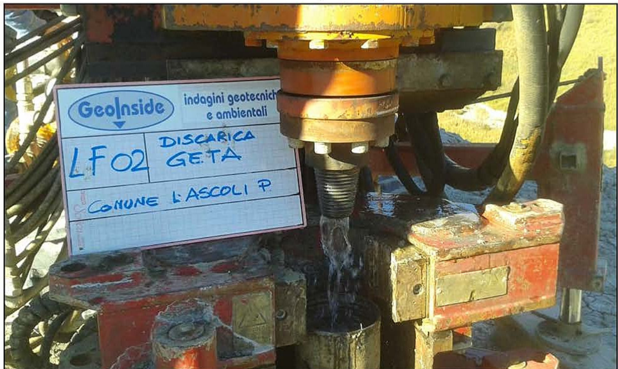
Foto 2 – Dettaglio Prova LF02 con immissione di acqua nel foro predisposto per la prova.
