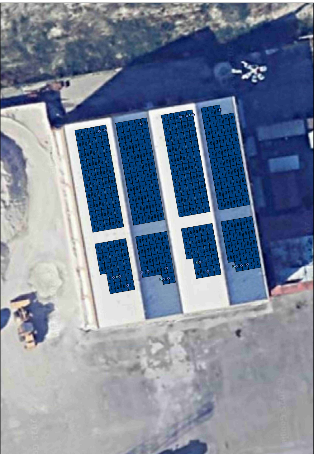
IMPIANTO FOTOVOLTAICO 130,5kWp
