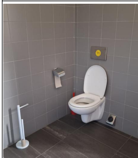
Servizi igienici accessibili Centro del lavoro
