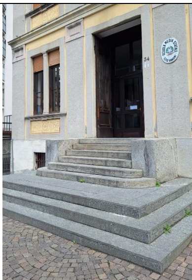
Ingresso Scuola media Vanoni
