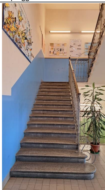
Scale di collegamento
