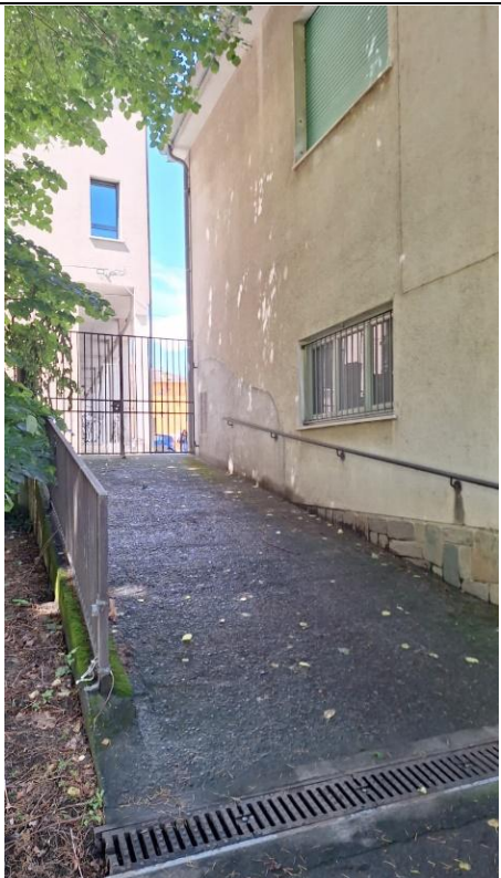
Rampa discesa piano seminterrato
