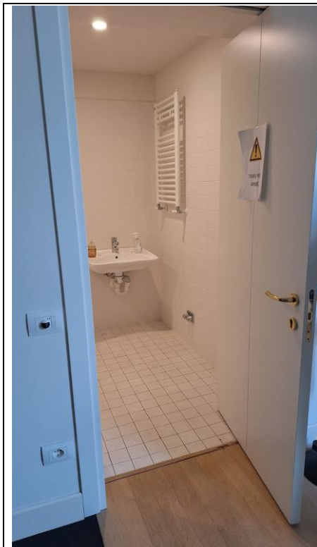
Servizi igienici dell'ostello esterni alle camere
