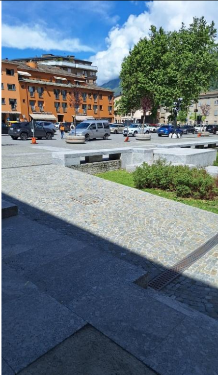
Rampa esterna ingresso Ostello
