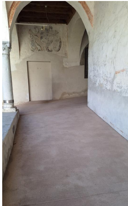
Rampa Ingresso Chiostro Sud
