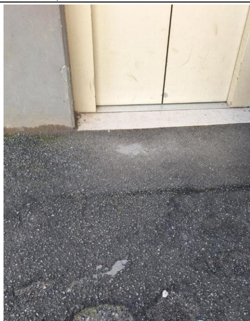
Pavimentazione cortile e percorso per ascensore
