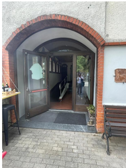
Ingresso accessibile (collegamento con ascensore)
