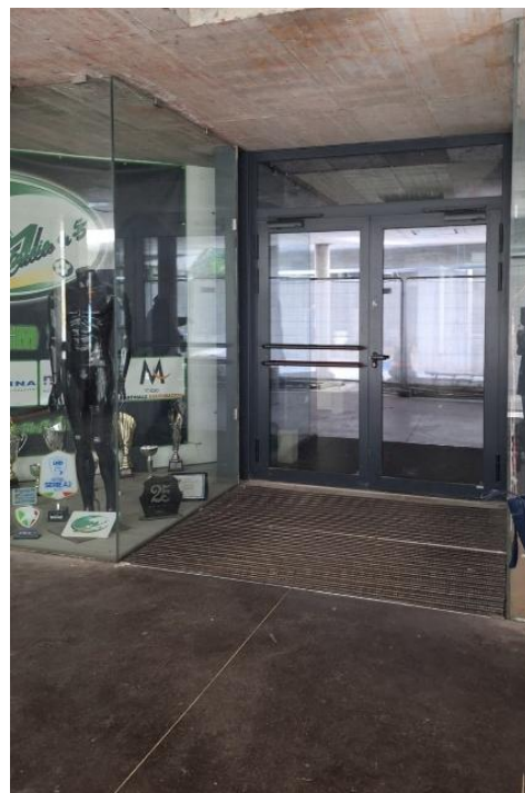
Ingresso spogliatoi accessibile
