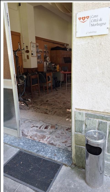
Ingresso locali seminterrato
