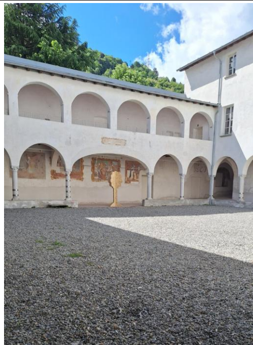
Pavimentazione Chiostro Sud
