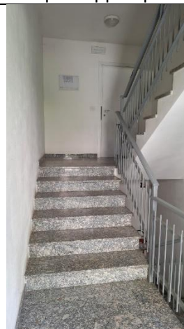
Scale e vano ascensore
