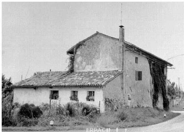
Fig. 3 La casa forte in via Blaserna in una foto storica precedente alla ristrutturazione.
