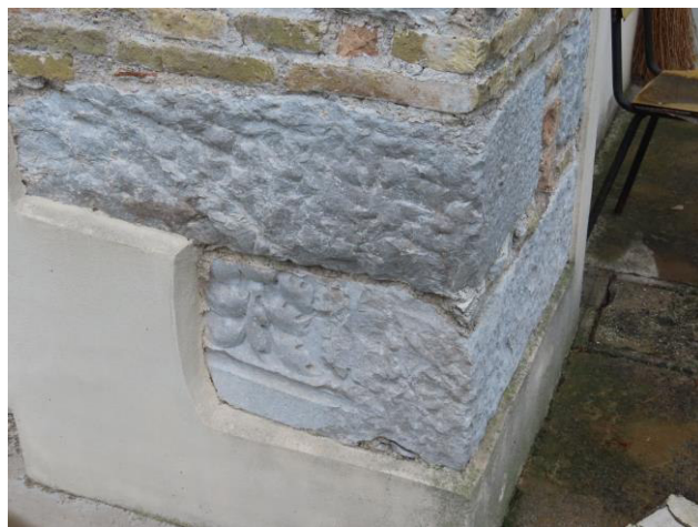
Fig. 5 L'elemento architettonico romano reimpiegato nel paramento esterno dell'abside della Chiesa di Santa Maria.
