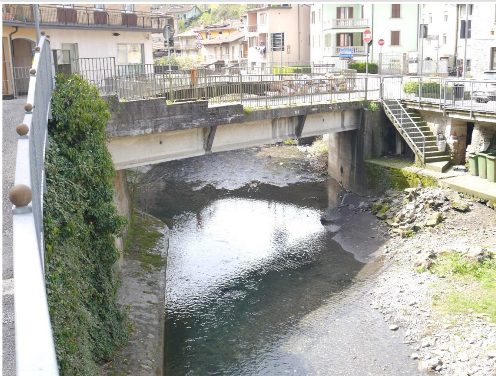
Foto 1 – Alveo del t. Brembilla nel centro abitato, vista verso valle
