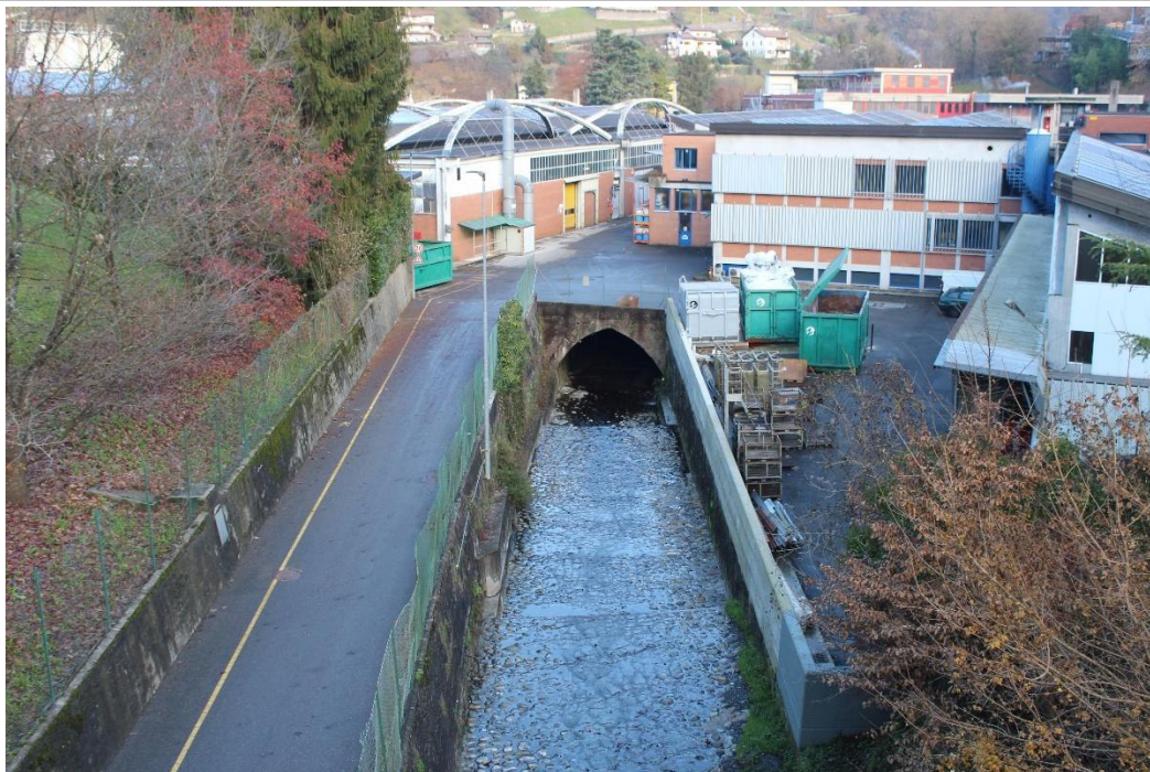
Foto 32 – Inizio del tratto intubato della Valle Cava (da q. 418,62 m s.l.m. a q. 407,04 m s.l.m.)
