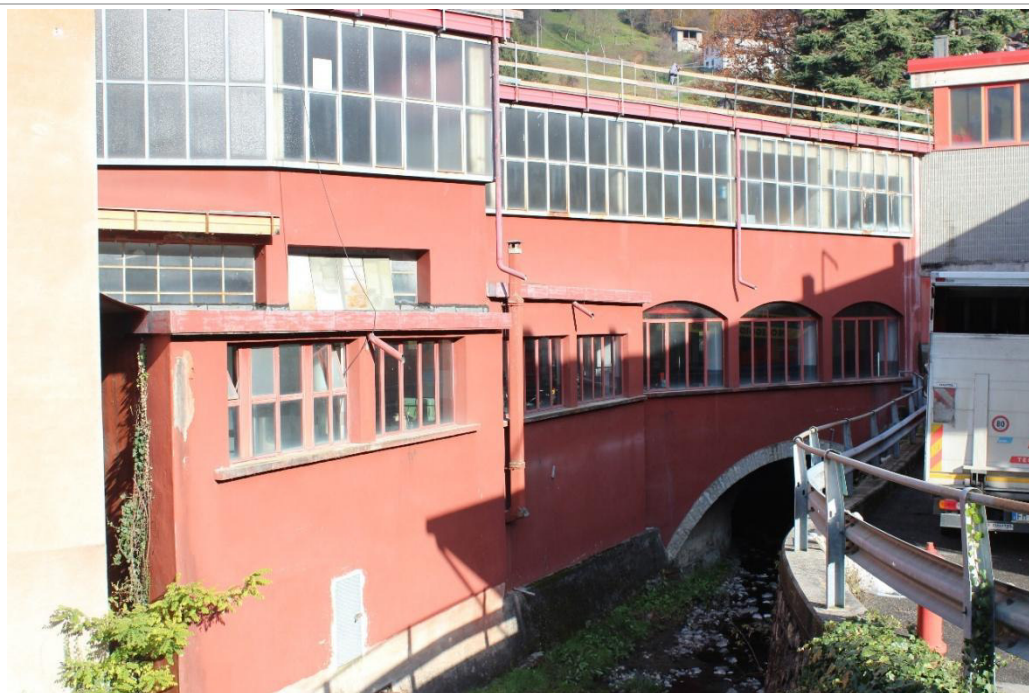
Foto 33 – Inizio del tratto intubato della Valle Cava (da q. 404,65 m s.l.m. a q. 405,93 m s.l.m.)
