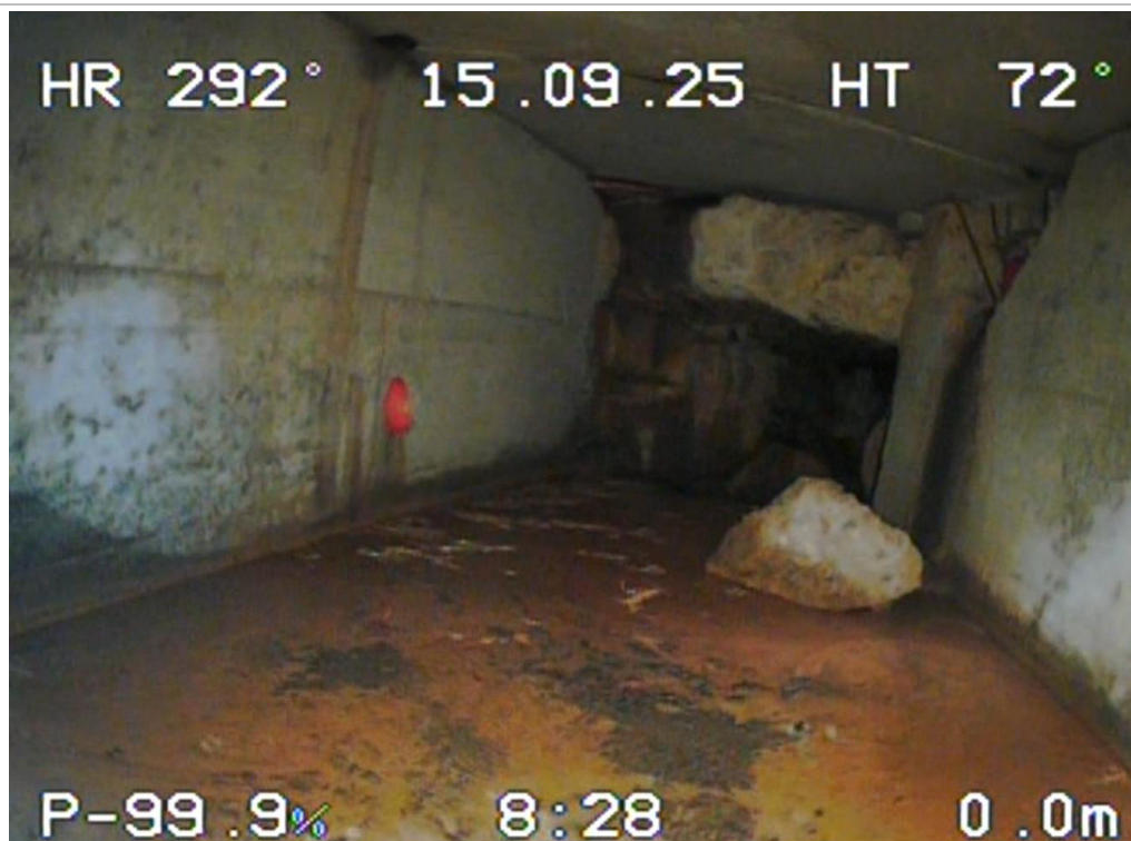
Foto 50 – Tratto intubato dell' Affluente Valle Zuccone SX III (Cod_RIM 03016253_0539) – da videoispezione
