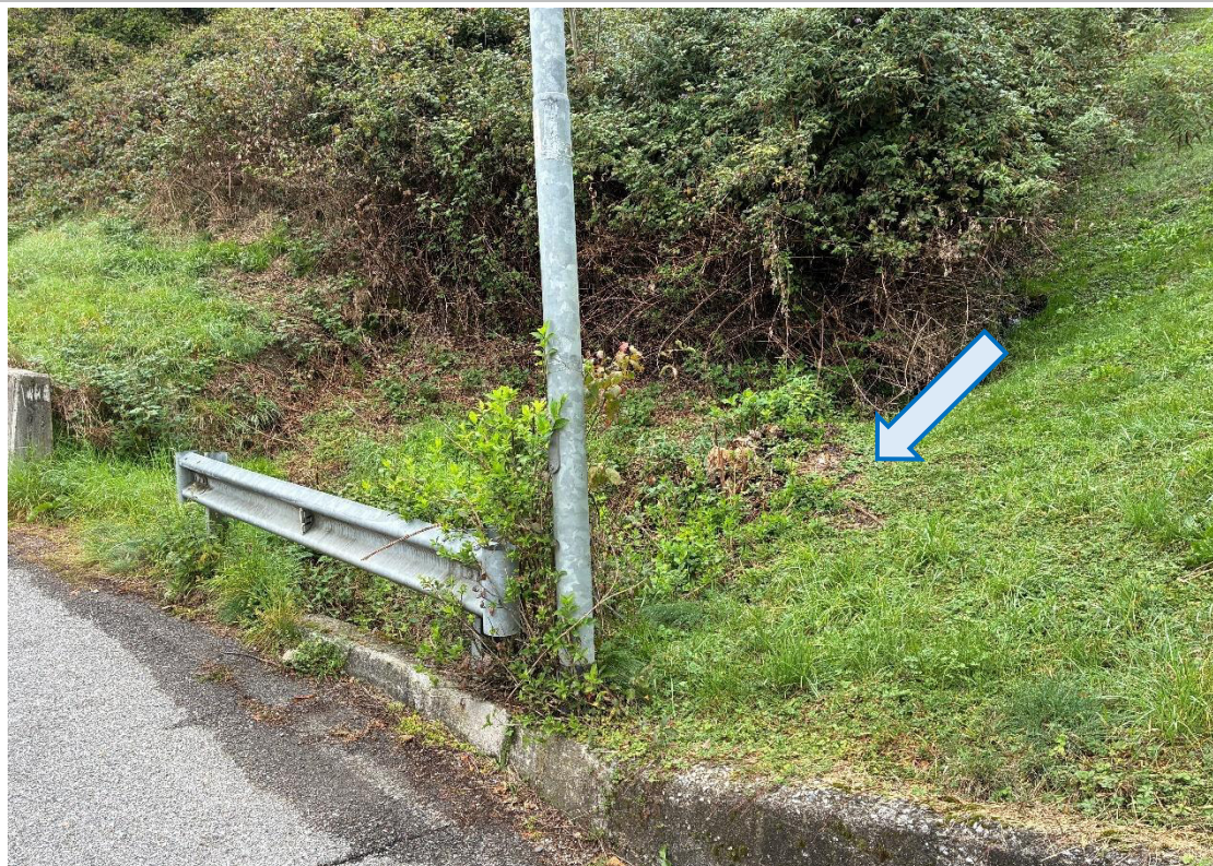
Foto 47 – Inizio del tratto intubato dell' Affluente T. Brembilla SX III (Cod_RIM 03016253_0125) in prossimità della svolta via Cadamone – via Ravagna
