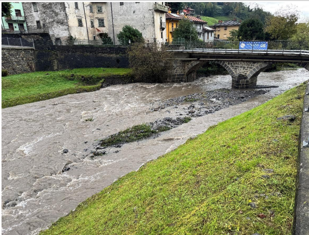
Foto 2 – Alveo del t. Brembilla nel centro abitato, vista verso valle
