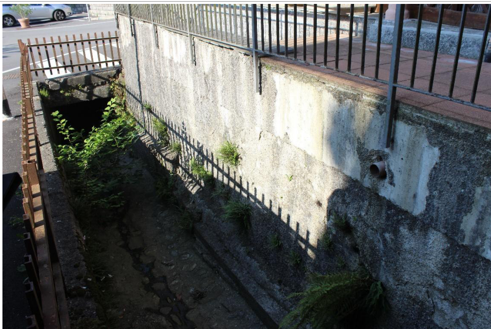
Foto 40 – Inizio del tratto intubato della Valletta dei Mulini - Laxolo (q. 523,62 m s.l.m.)
