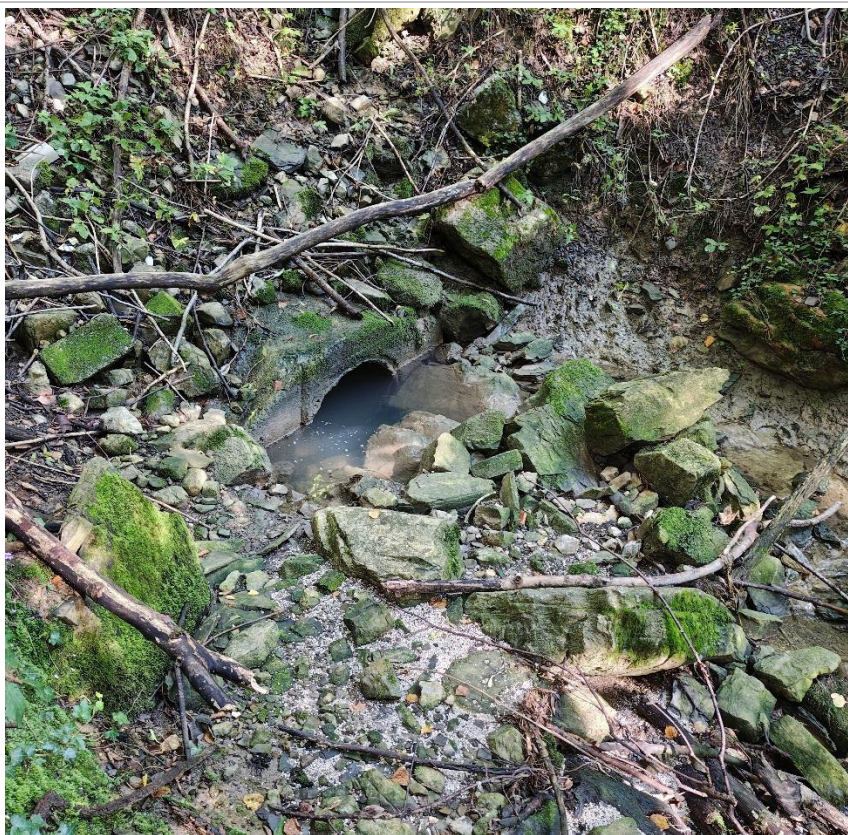
Foto 52 – Fine del tratto intubato dell' Affluente Valle Zuccone SX III (Cod_RIM 03016253_0539)
