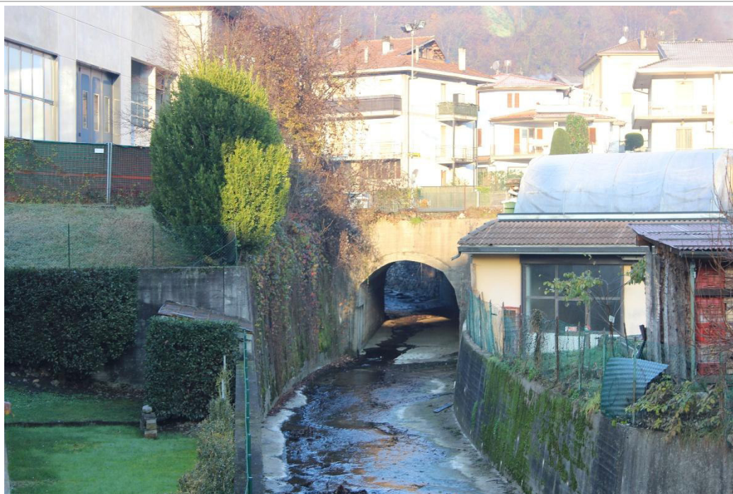
Foto 30 – Porzione di alveo intubato della Valle Porno (da q. 432,51 m s.l.m. a q. 430,91 m s.l.m.) – vista verso monte
