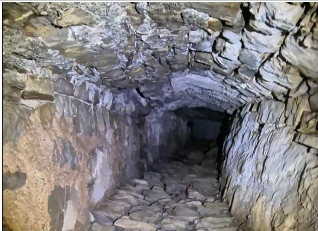
Foto 51 – Tratto intubato dell' Affluente Valle Zuccone SX III (Cod_RIM 03016253_0539) – da videoispezione
