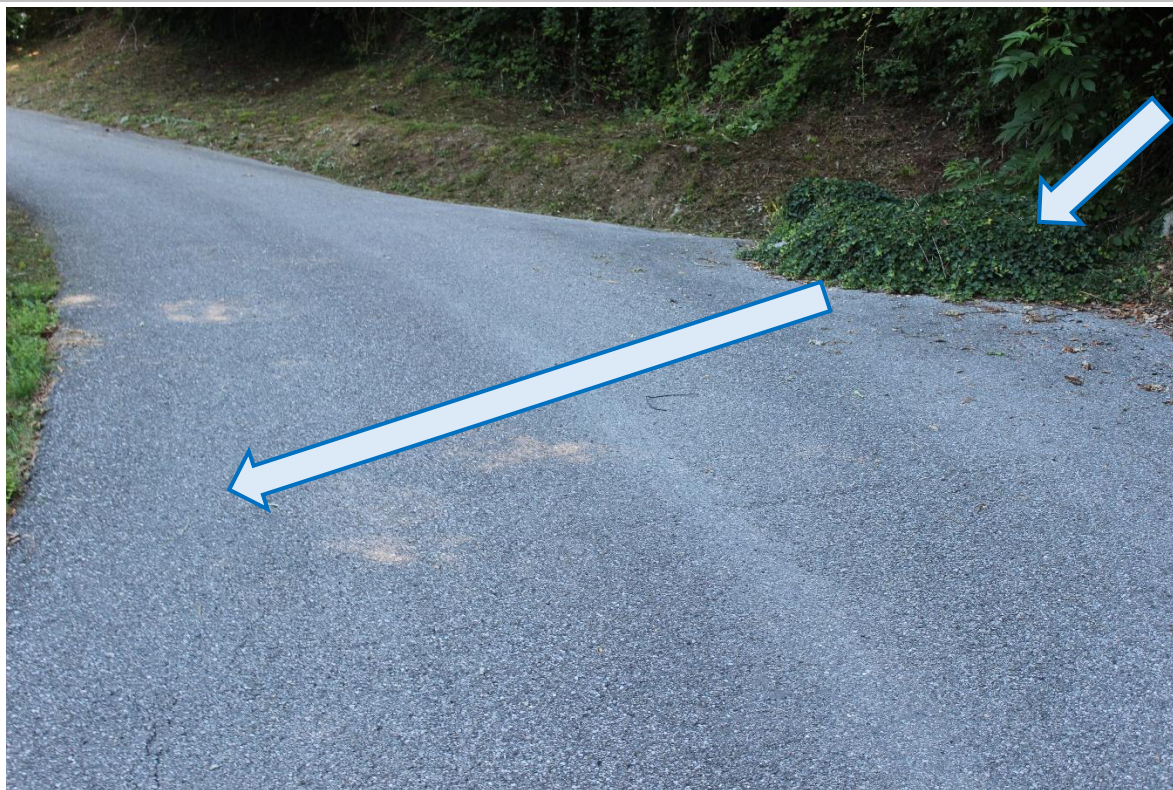
Foto 44 – Attraversamento dell’Affluente Valle della Tenuta - Ca' Moroni DX IX (Cod_RIM 03016253_0036) al di sotto della strada privata in loc. Casellone (Freccia blu)
