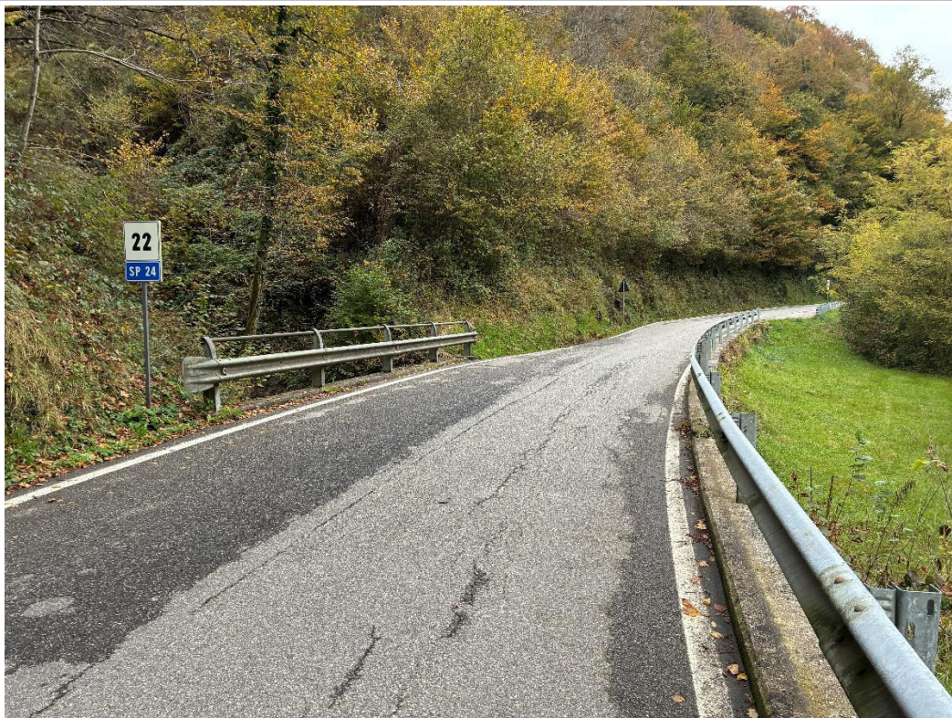
Foto 26 – Punto di attraversamento della SP 24 del Canale dell'Alluera
