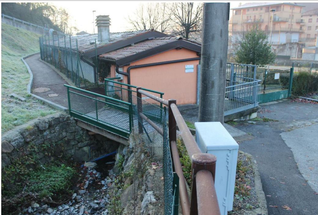
Foto 19 – Inizio del tratto intubato della Valle di Grumello in prossimità del laghetto artificiale
