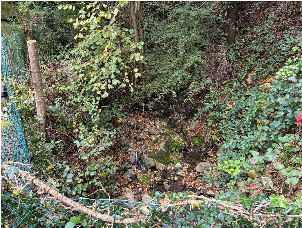
Foto 18 – Inizio del tratto intubato di via Donizzetti della Valle di Grumello
