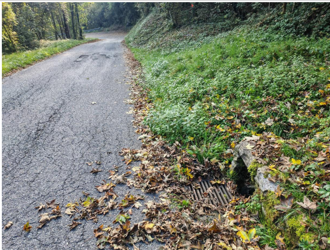
Foto 60 – Inizio del tratto intubato della Valletta loc. Cimitero (Cod_RIM 03016253_0658) in prossimità della via Valletta
