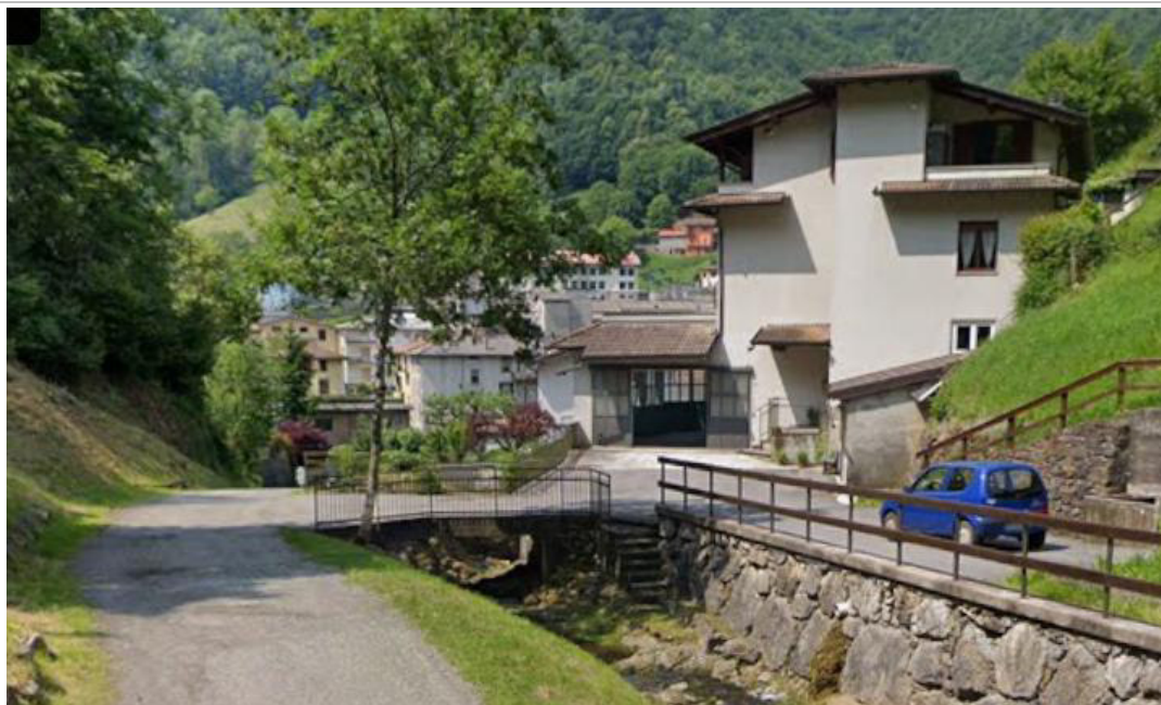
Foto 14 – Alveo della Valle dei Tufi a monte del centro urbanizzato (vista verso valle)
