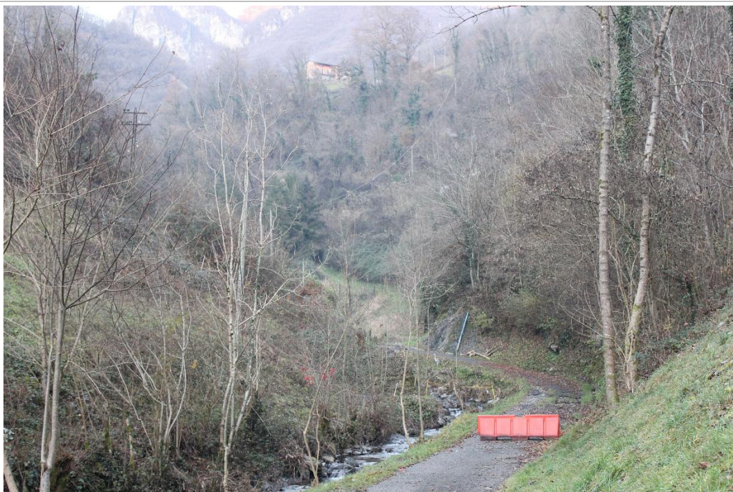
Foto 13 – Alveo della Valle dei Tufi a monte del centro urbanizzato (vista verso monte)
