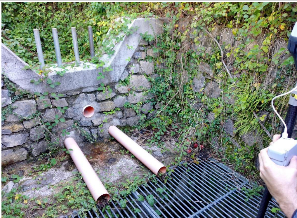
Foto 49 – Inizio del tratto intubato dell’ Affluente Valle Zuccone SX III (Cod_RIM 03016253_0539)
