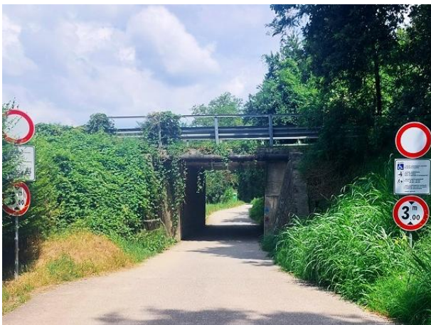
Sottopassi pedonali – Via Diaz
