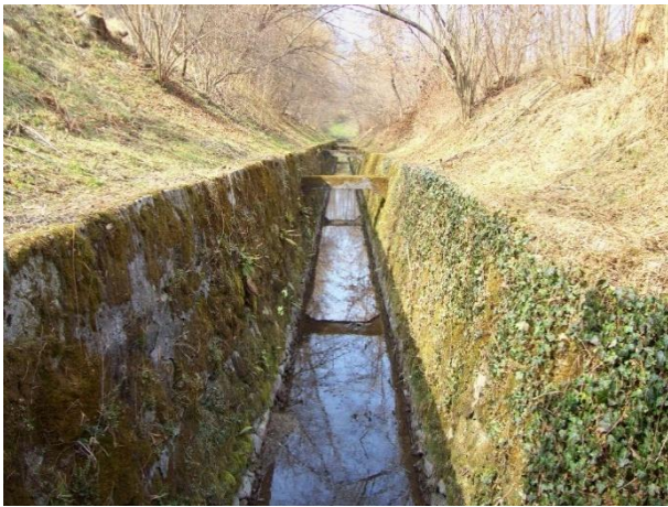
Canali storici – Roggia Borromeo
