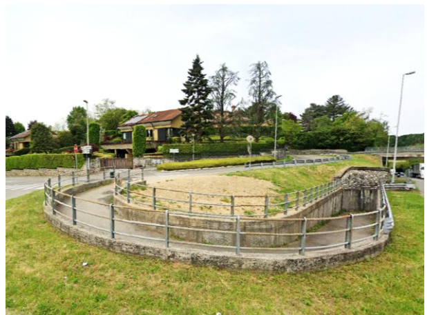
Sottopassi pedonali – Viale Rimembranze
