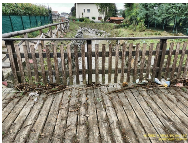
Ponte pedonale scavalcato per circa 25 cm dalla corrente al picco della portata della R. Vecchia
