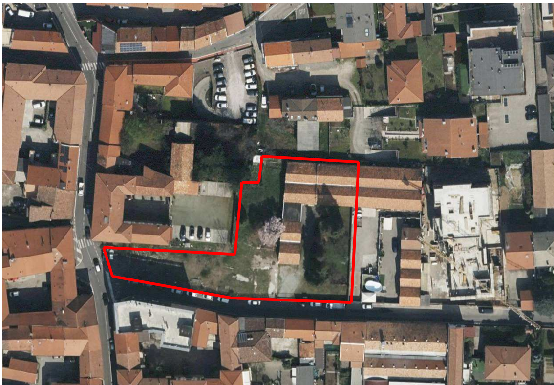
Vista zenitale dopo la demolizione del cinema
