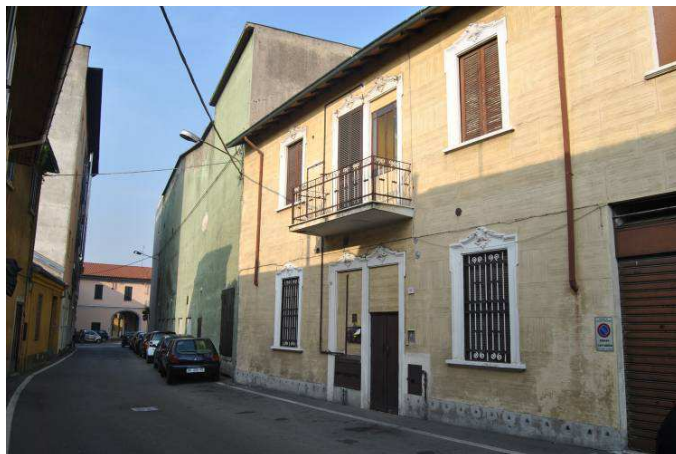
Vista da Via Luini prima della demolizione
