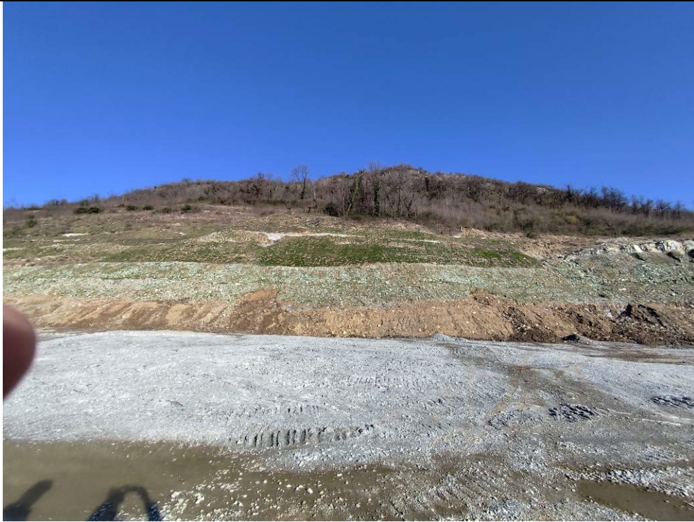
Vista frontale versante Nord
