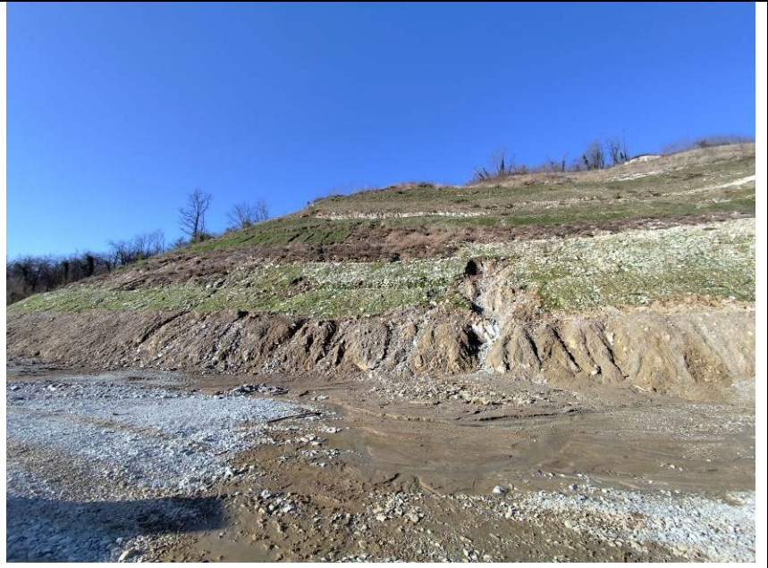
Viste del fronte NW, Nella foto di destra si mostra l'erosione lineare originatasi a seguito delle precipitazioni di metà marzo 2026
