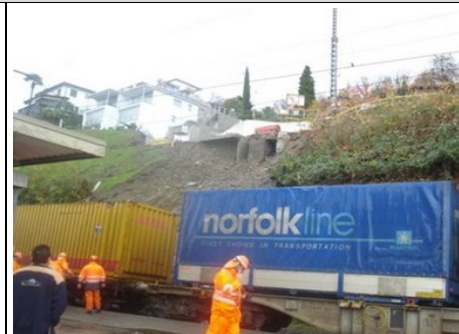
San Nazzaro (CH) – frana su linea - 11/2008
