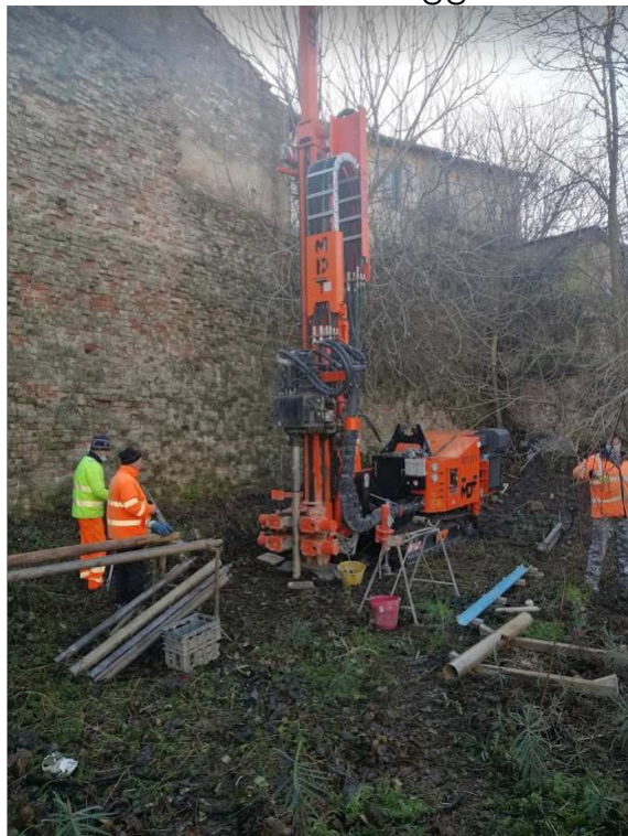
Esecuzione Sondaggio S1
