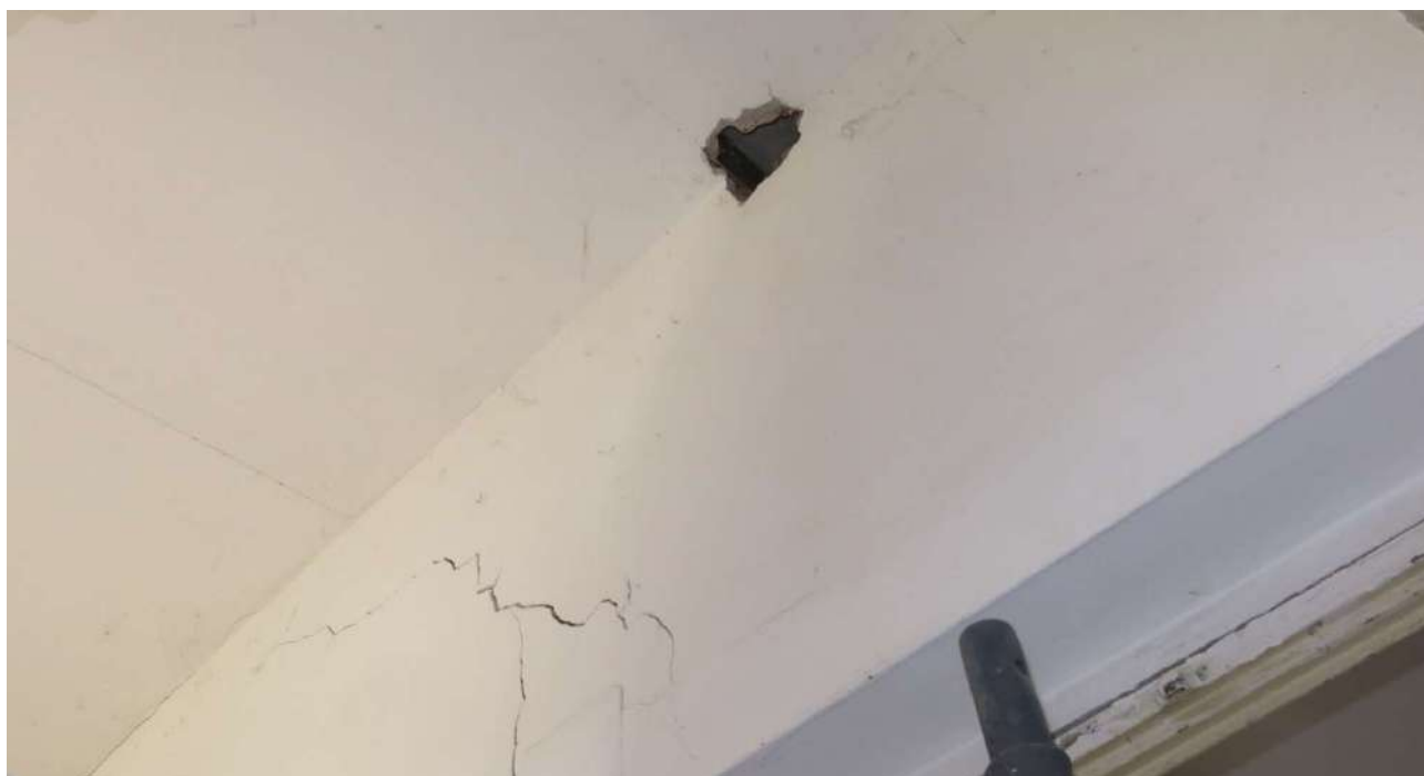
Foto 15: piano terra soletta di copertura locale F-G con quadro fessurativo e due tipologie di soletta (in putrelle e tavelloni, prima del muro divisorio); in legno (dopo il muro) - foto del 2024, prima delle opere BANDO GIOVANI INSIEME
