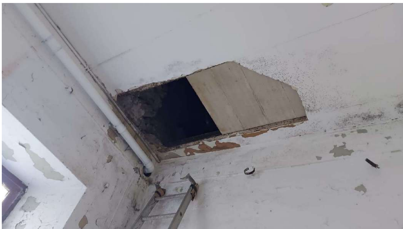
Figura 29_ Fotografia attuale da soffitto locale C con un varco di accesso esistente. E' visibile la soletta realizzata nel seconda metà del '900 con putrelle in ferro e tavelloni. Tale tipologia di copertura – peraltro in precarie condizioni di conservazione – è la stessa dei locali A-B-C-D-E
