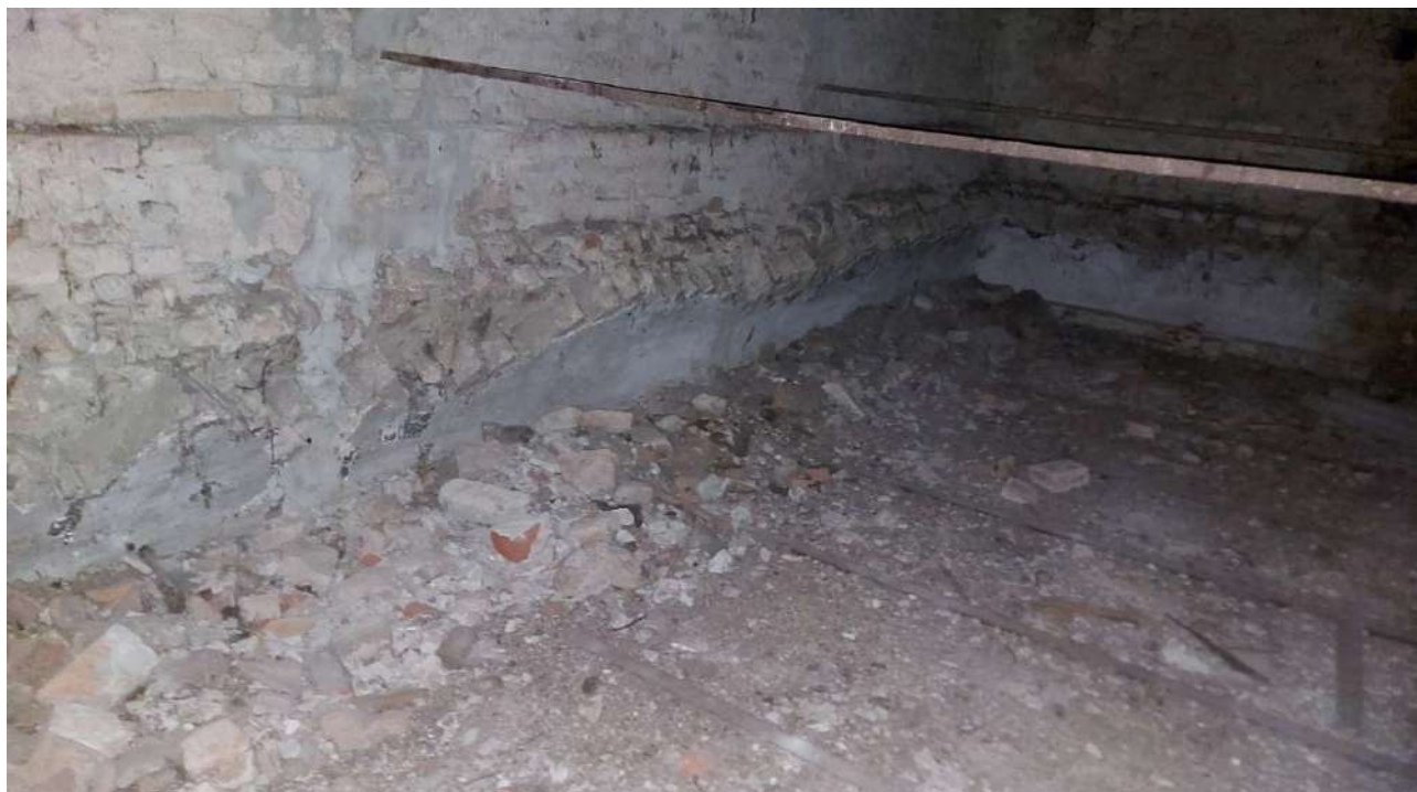
Figura 28_ Fotografia attuale dal sottotetto locali A-B-C-D-E con la soletta realizzata nel seconda metà del '900 con putrelle in ferro e tavelloni
