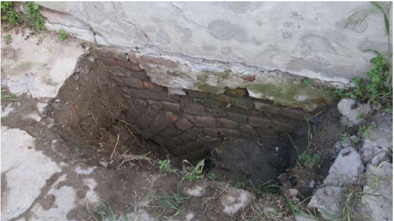
figura 31: fotografia dello scavo del saggio “sc Fon 2” eseguito nel 2024 all'esterno dell'edificio a ridosso della facciata sud-ovest che rivela un terreno argillo limoso al di sotto del marciapiede esistente e la fondazione ad arco
