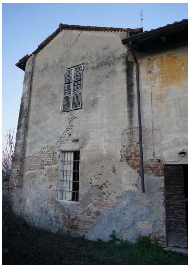
Foto 5: Particolare del fronte sud-ovest con il quadro fessurativo nella parte centrale - foto del 2024, prima delle opere BANDO GIOVANI INSIEME
