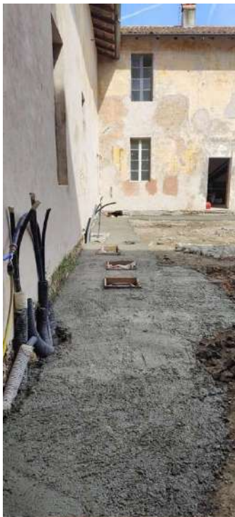
figura 60: vista delle reti interrate esistenti già realizzate nel cortile del Castello (fossa biologica ed altri impianti di fronte della finestra locale B – dopo posa di massetto di protezione)
