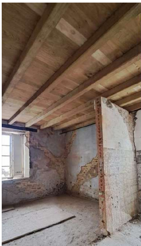
figura 36: fotografia del locale F con soletta restaurata ed interventi di cuciture armate/cuci scuci già eseguite
