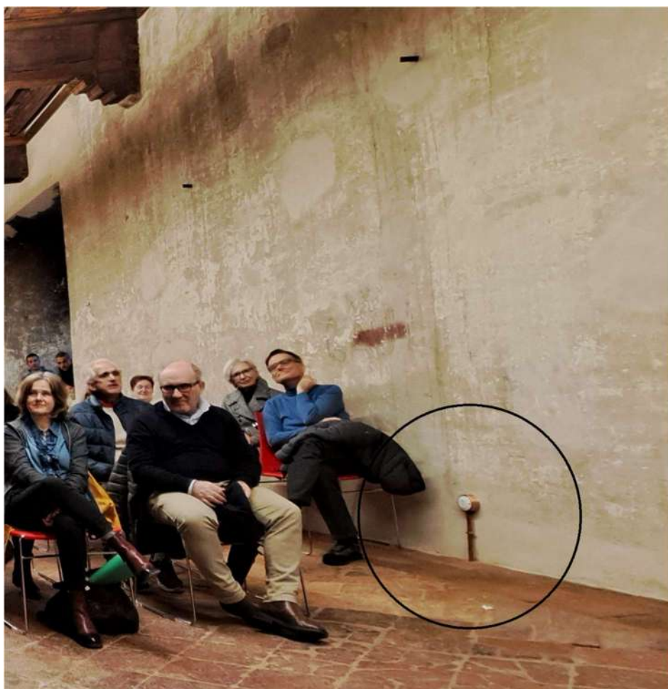
figura 54: tipologia di impianti elettrici a vista in rame già esistenti all'interno del Castello
