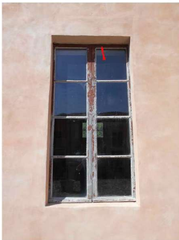
Foto 17 Serramento D; esterno. Stato di fatto. La freccia indica la posizione del saggio stratigrafico sul manufatto.
