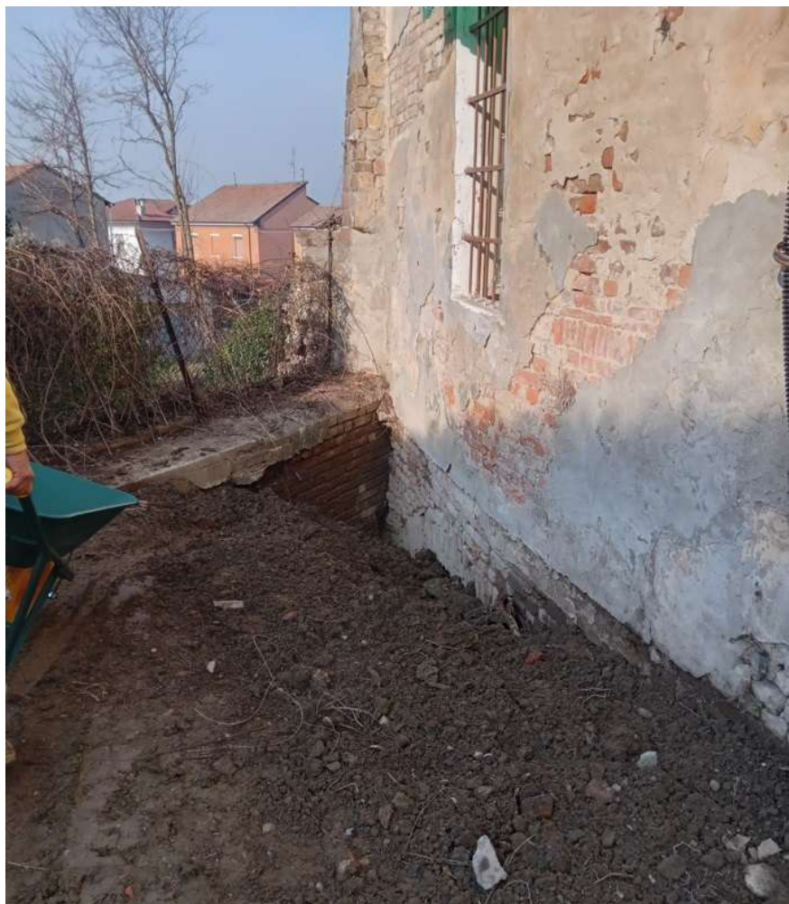
figura 32: fotografia dello scavo eseguito nel 2022/2023 all'esterno dell'edificio a ridosso della facciata sud-ovest dei locali F con presenza della fondazione ad arco
