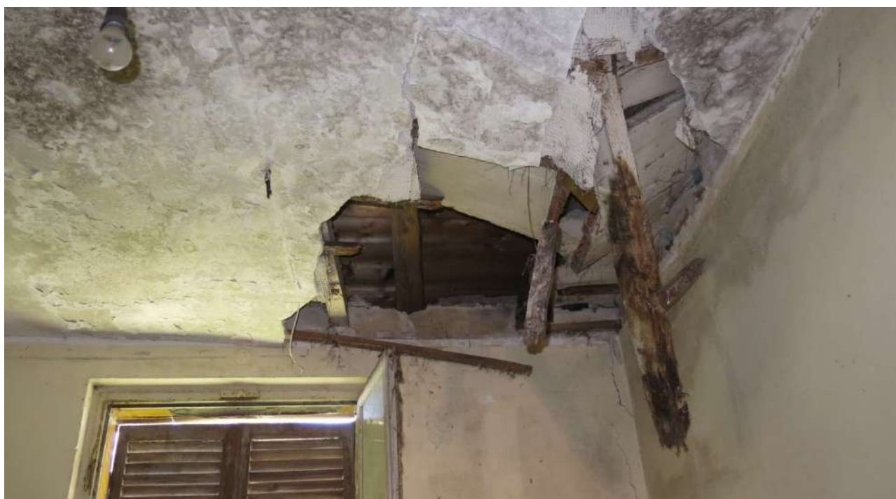
Foto 16 Crollo puntuale nella soletta di copertura del locale dell'ala nord-ovest. AMBIENTI NON OGGETTO DEL BANDO GIOVANI INSIEME E NEPPURE DEL BANDO MINISTERO DEL TURISMO.
