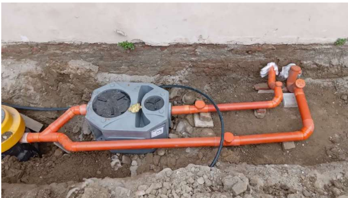
figura 59: vista delle reti interrante esistenti già realizzate nel cortile del Castello (fossa biologica ed altri impianti di fronte della finestra locale B). E' presente anche una predisposizione di scarico ulteriore.
