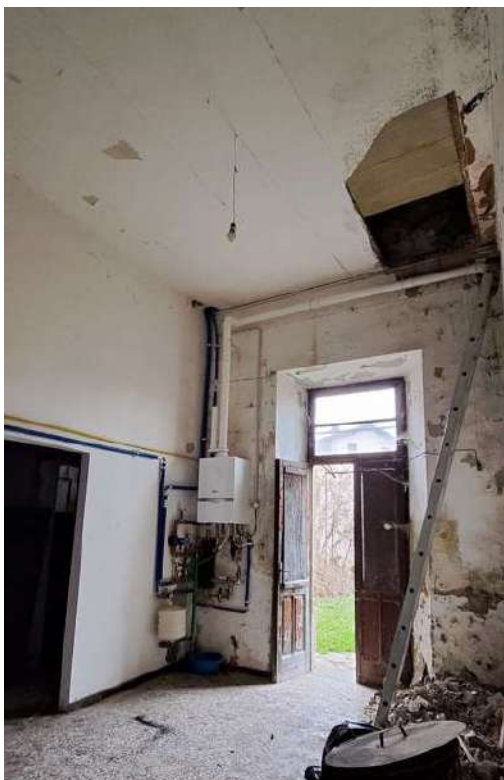
figura 61: caldaia esistente locale C da ricollocare nel sottotetto
