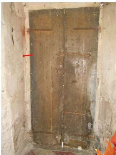
Foto 5 Serramento B; interno. Stato di fatto. La freccia indica la posizione della stratigrafia sul manufatto.
