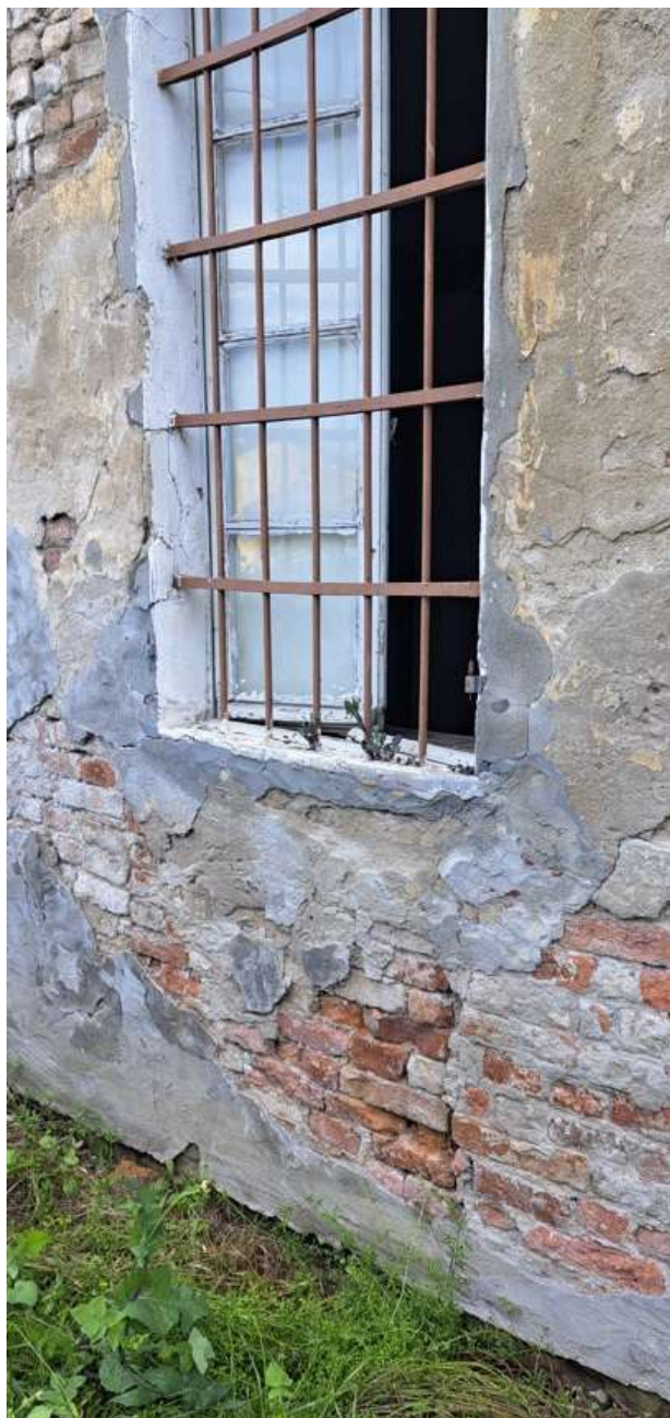
Foto 12: Particolare del fronte sud-ovest, finestra ambiente ex-bagno piano terra, ove si riconosce la presenza di una pregressa porta-finestra, poi tamponata (locale A)
