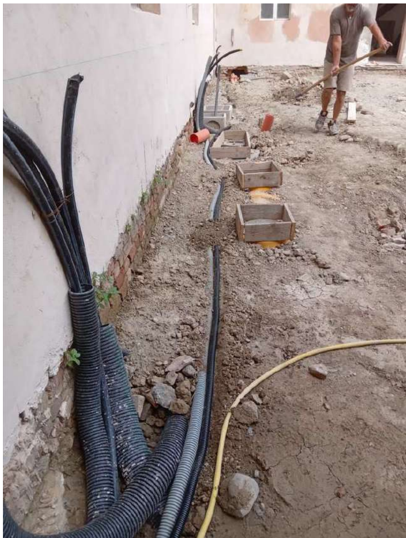
figura 57: vista delle reti interrante esistenti già realizzate nel cortile del Castello (evidenziate con dei casseri in legno sono le ispezioni delle fosse biologiche di fronte della finestra locale B)
