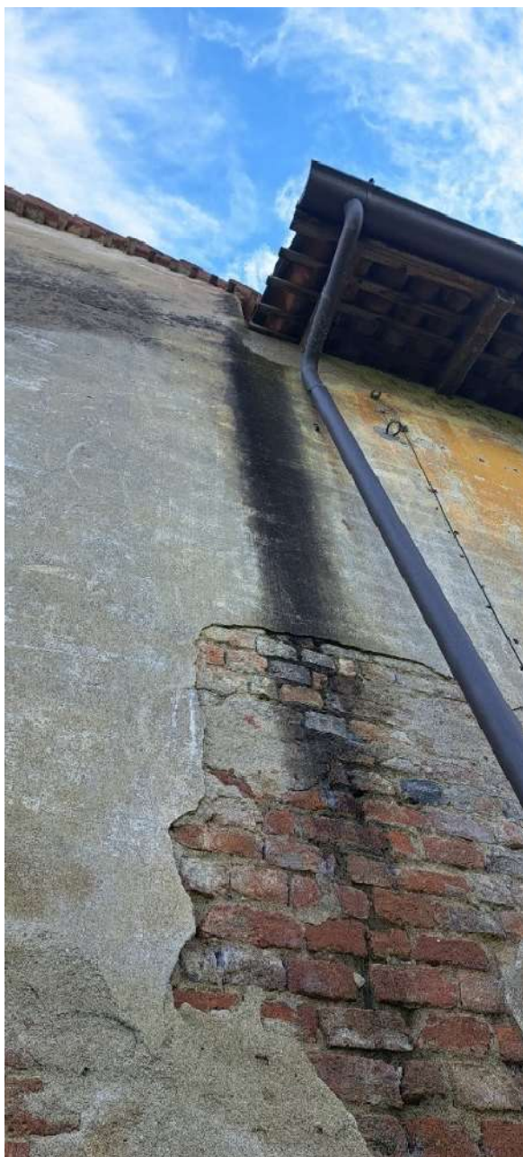
Foto 20: fronte sud-ovest: particolare degli intonaci con i prevalenti fenomeni di degrado presenti tra mancanze di intonaci e percolamenti delle acque dalle coperture con conseguenti danni agli intonaci
