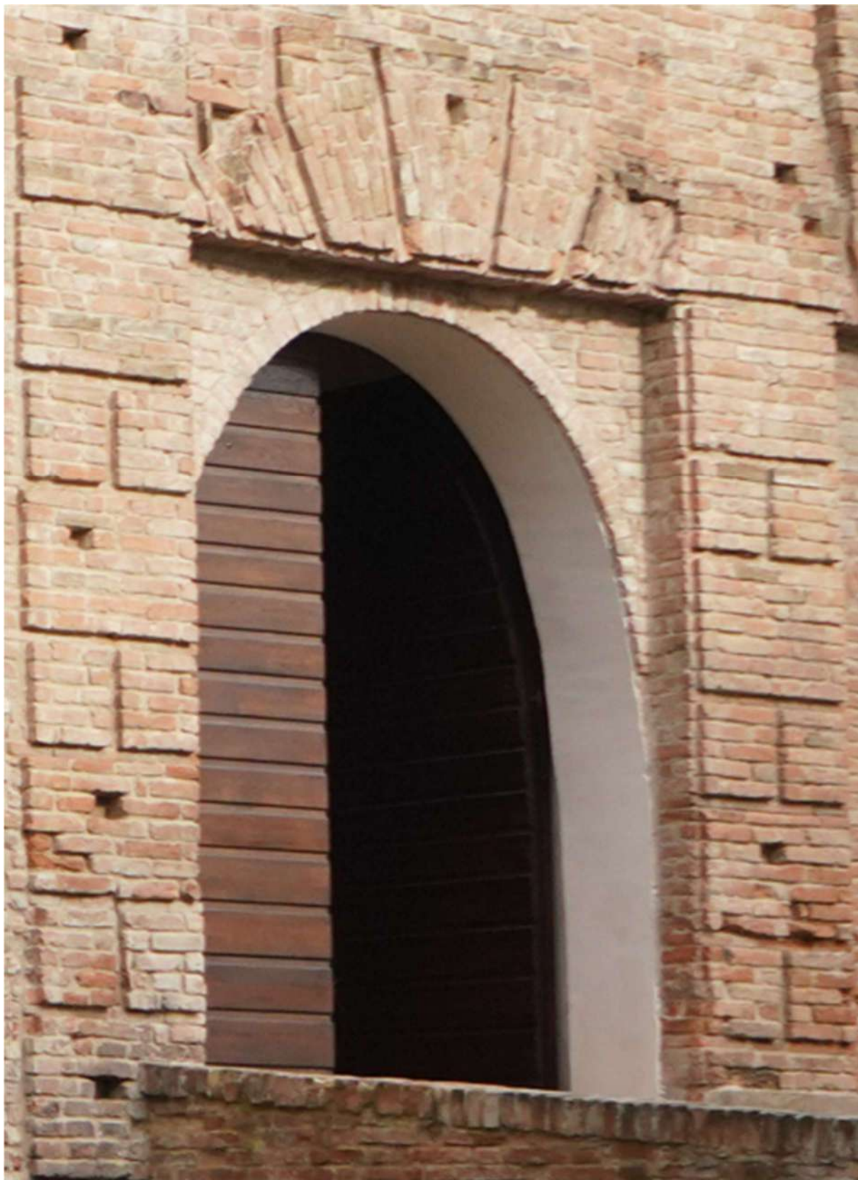
figura 50: Dettaglio della cromia/texture dell'impregnante del portone di ingresso al Castello, cromia da usare come riferimento per i nuovi serramenti di progetto e per il restauro di quelli esistenti
