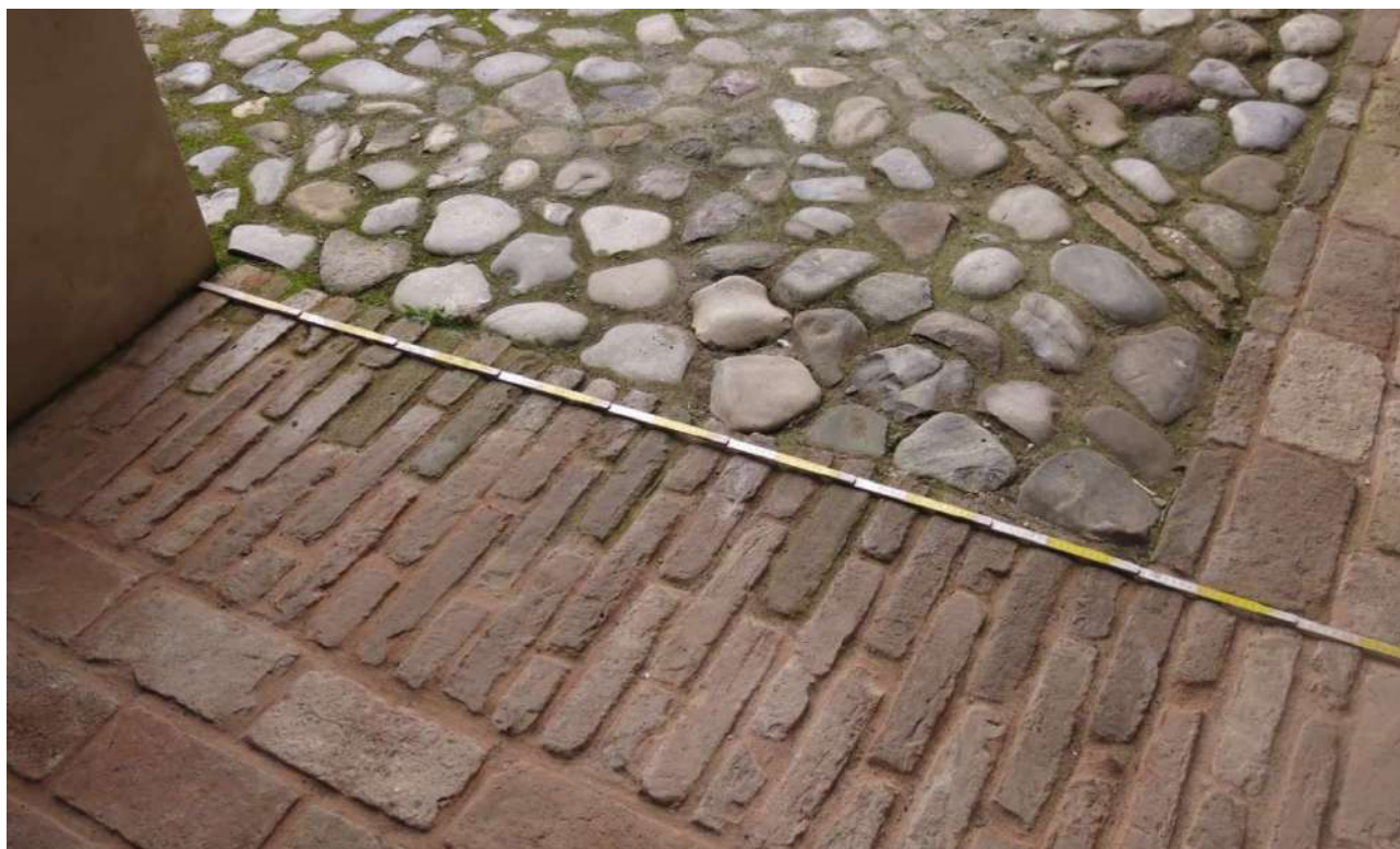
figura 51: Pavimenti esistenti nel cortile del Castello. Il pavimento in primo piano realizzato in conci di cotto posati di taglio è quello che si propone di replicare nelle soglie di ingresso dei locali; il pavimento sulla destra (in lastre) è quello scelto per il pavimento dei nuovi marciapiedi
