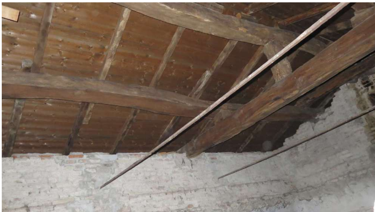
Foto 21: Vista della copertura del locale sottotetto H con le capriate, travi principali, assitto in legno e tiranti oggetto dell'intervento del 2018. Sulla destra si intravede la canna fumaria 30 x 70 che, previo alcune modifiche, verrà utilizzata anche per lo scarico della cappa delle CUCINE FRANCIGENE
