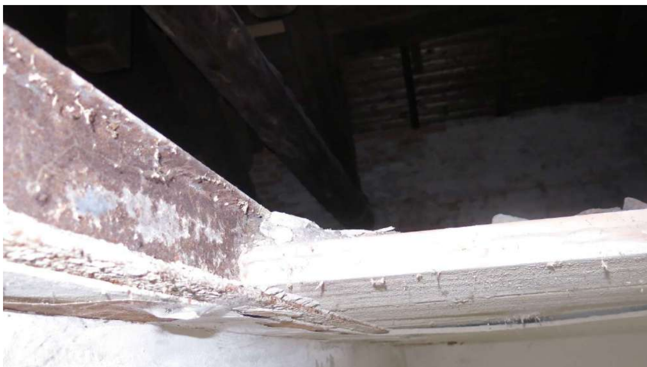
Foto 17 Soletta in putrelle e tavelloni di copertura dei locali A-B-C-D-E oggetto del presente progetto esecutivo
