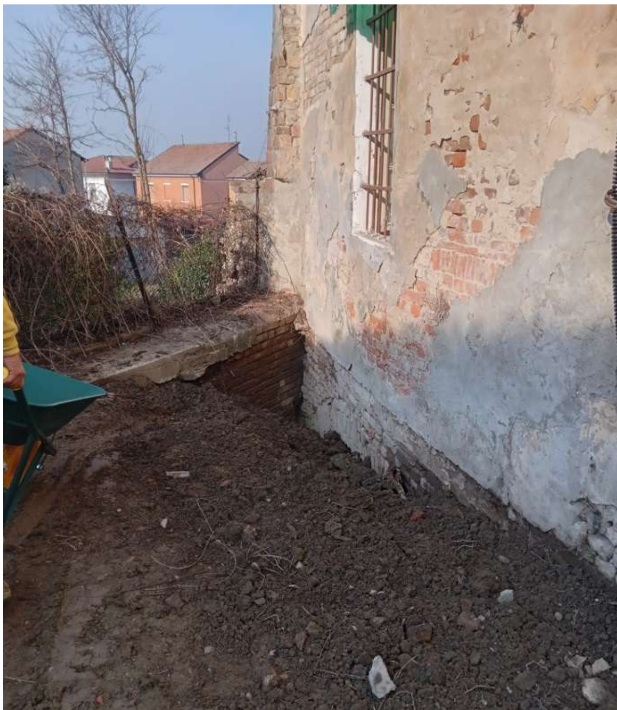
Foto 7: Particolare del fronte sud-ovest durante la campagna di scavi archeologici eseguiti nel 2022-2023 (arch.Galluppi) con le fondazioni ad arco sotto il piano "0" – foto del 2022-2023
