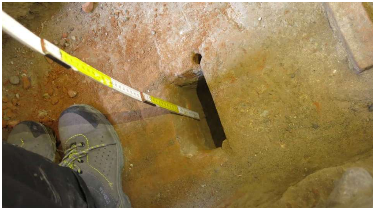
Figura 33_ fotografia dello scavo del saggio "sc Poz 2" eseguito nell'ambiente C con evidenza dello spessore della volta
