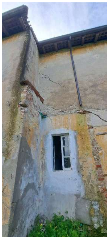
Foto 22: Vista del fronte nord-ovest, locali G e F con discontinuità del pluviale/discendente - foto del 2024, prima delle opere BANDO GIOVANI INSIEME
