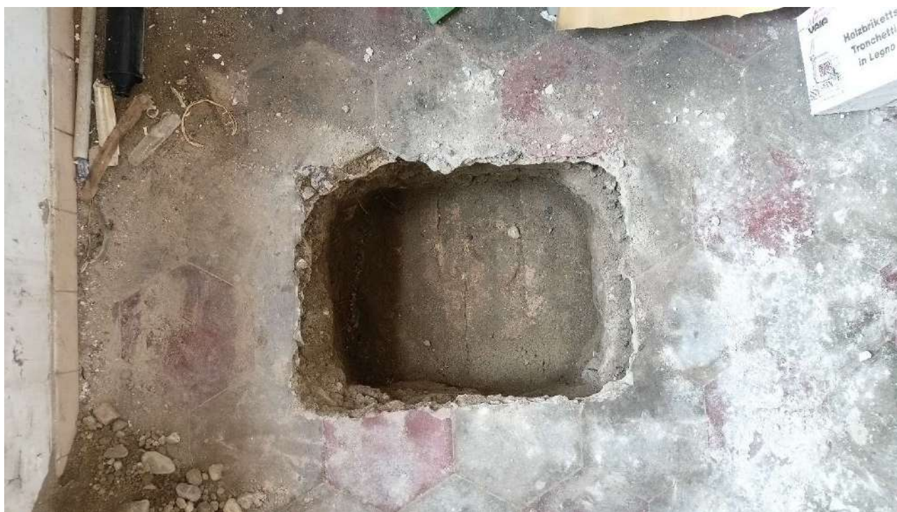
Figura 35_ fotografia dello scavo del saggio “sc Poz 3” eseguito nell'ambiente B che rivela una volta laterizia sotto la pavimentazione moderna esistente, vista zenitale.
