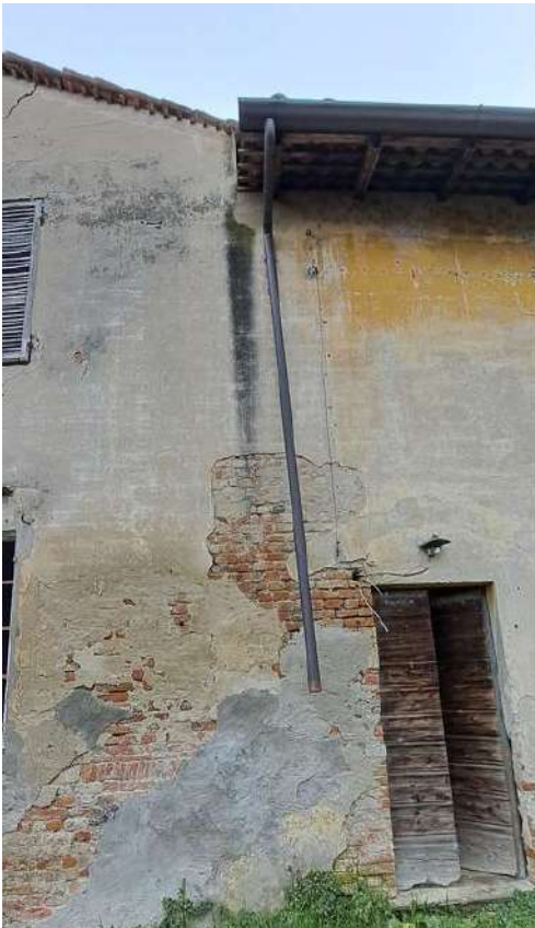
figura 47: degrado su intonaci connesso al mancata gestione delle acque meteoriche e correntini a vista
