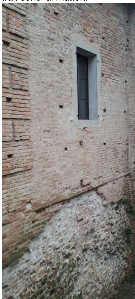
Figura 42: Vista della finestra vicina al ponte pedonale che evidenzia la cromia delle fughe di calce tra i conci di mattoni e la bordatura della finestra in intonaco colore grigio
