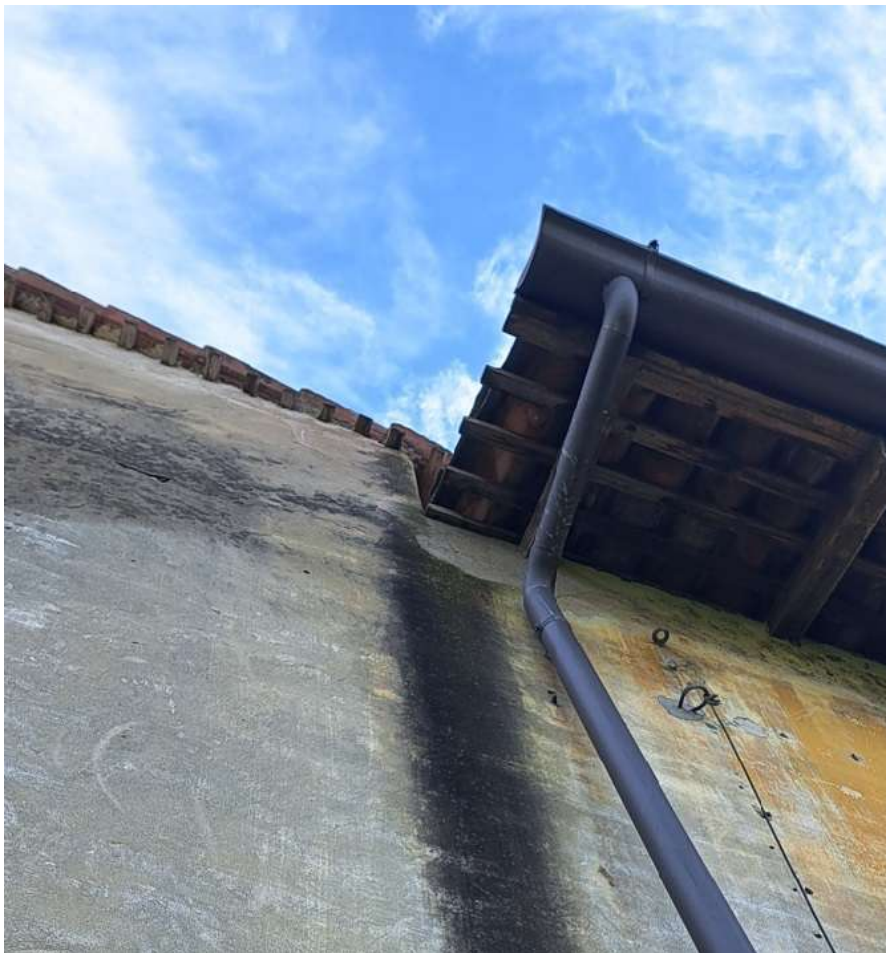
figura 49: degrado su intonaci connesso al mancata gestione delle acque meteoriche
