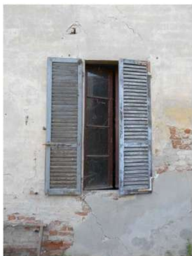
Foto 1 Serramento A: esterno. Stato di fatto. Non sono stato in grado di chiudere il battente sinistro che al momento è bloccato.
