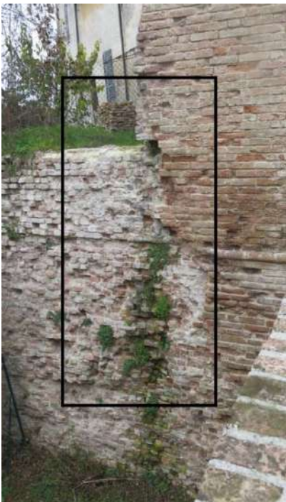
figura 48: degrado sulle pareti del fossato connesso ad una imperfetta gestione delle acque meteoriche. Si notino le efflorescenze e la vegetazione sulla parete storica.
