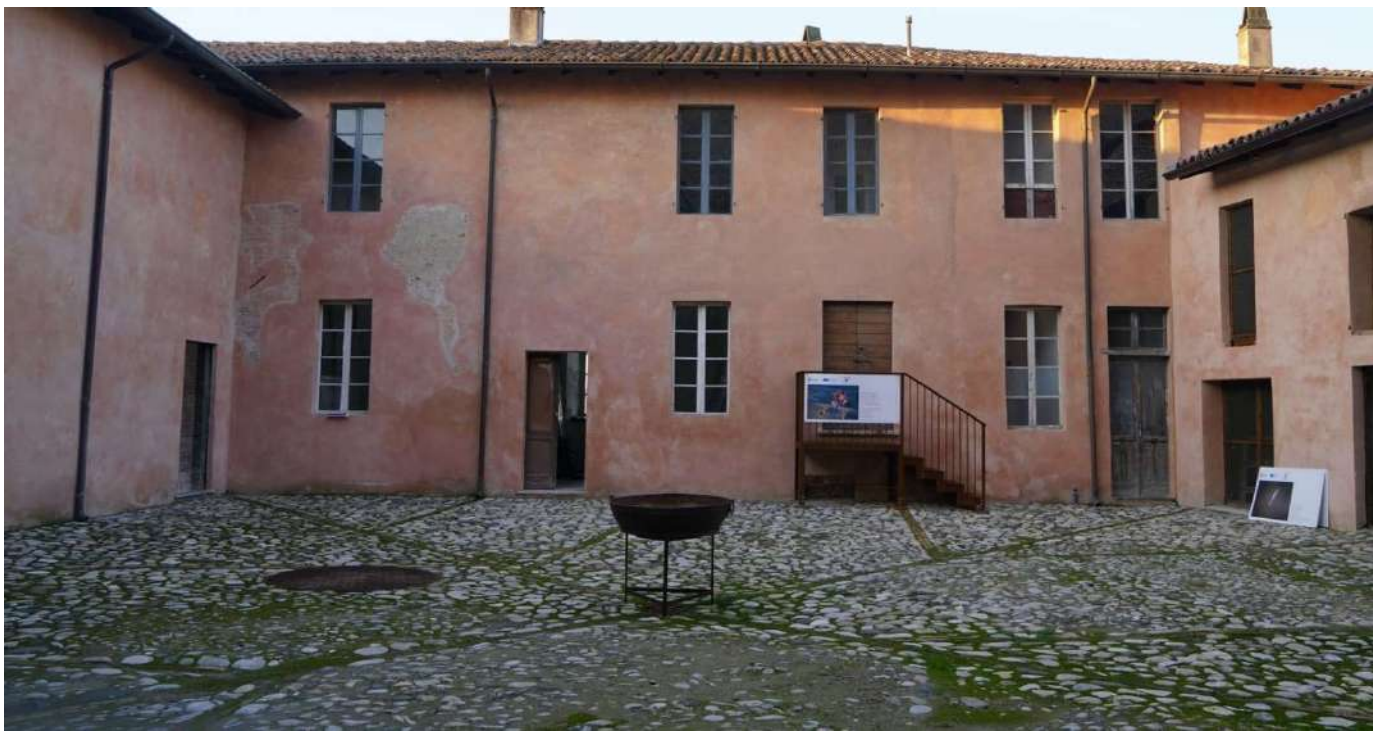
figura 52: Pavimenti esistenti nel cortile del Castello. Il fondo a sinistra la porta in ingresso alle cucine francigene (con gradino di ingresso); il primo piano il pavimento in ciottolato con diagonali in laterizio
