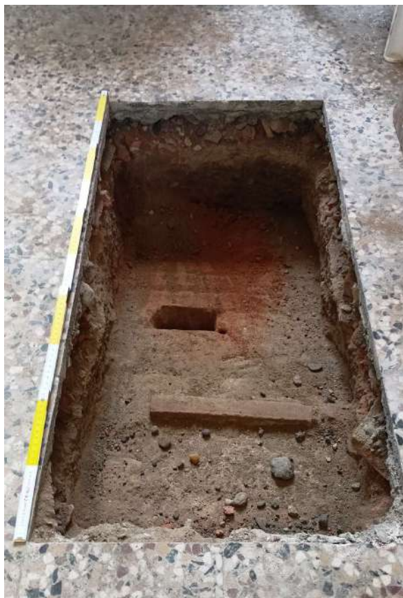
Figura 34_ fotografia dello scavo del saggio “sc Poz 2” eseguito nell'ambiente C che rivela una volta laterizia sotto la pavimentazione moderna esistente, vista prospettica.
