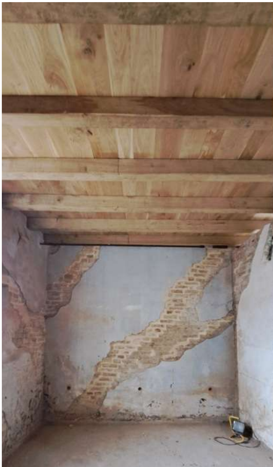
figura 37: fotografia del locale F con soletta restaurata ed interventi di cuciture armate/cuci scuci già eseguite
