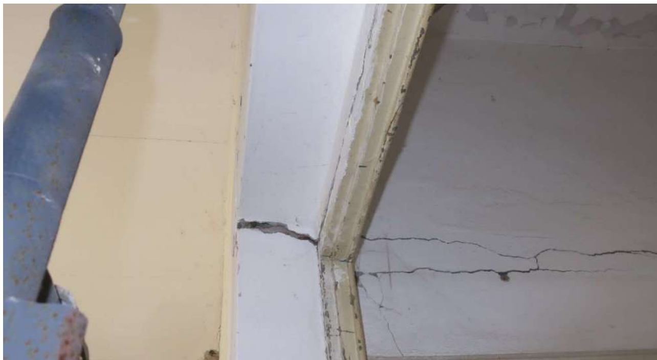
Foto 14: piano terra soletta di copertura locale F-G con quadro fessurativo e due tipologie di soletta (in putrelle e tavelloni, lato Sinistro); in legno (lato destro del muro) - foto del 2024, prima delle opere BANDO GIOVANI INSIEME
