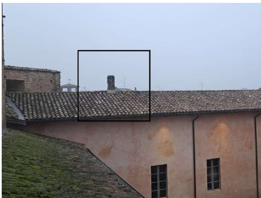
figura 63: Canna fumaria esistente presente nel sottotetto con comignolo in cemento prefabbricato vista dall'esterno che viene resa più coerente con l'edificio storico grazie al progetto trasformando le parti a vista in muratura ed intonaco
