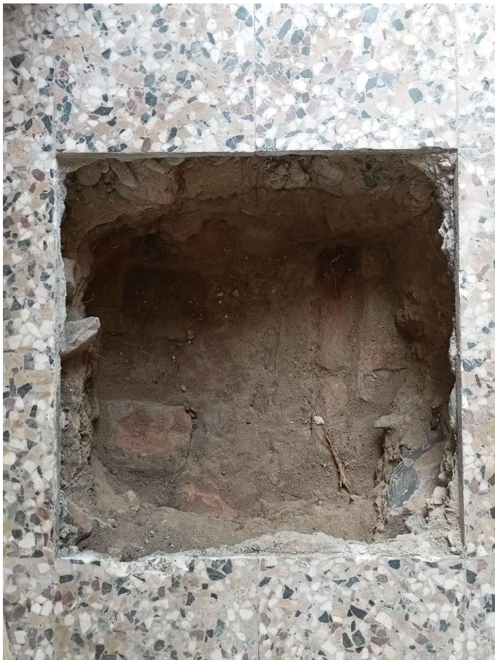
Figura 31_ fotografia dello scavo del saggio “sc Poz 4” eseguito nell’ambiente C che rivela una volta laterizia sotto la pavimentazione moderna esistente, vista zenitale.
