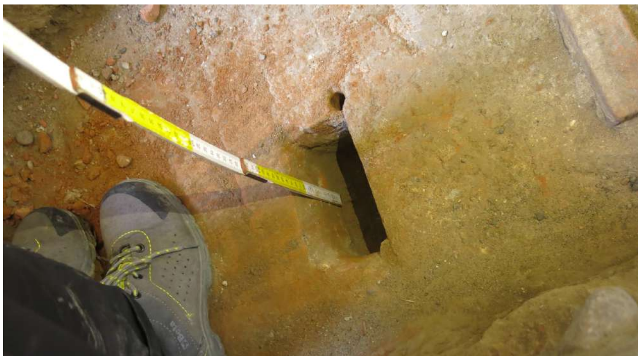
Figura 29_ fotografia dello scavo del saggio “sc Poz 2” eseguito nell’ambiente C con evidenza dello spessore della volta
