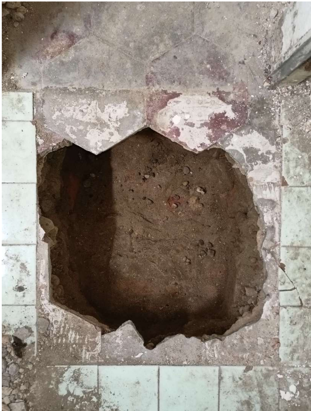
Figura 26_ fotografia dello scavo del saggio “sc Poz 1” eseguito nell’ambiente A che rivela una volta laterizia sotto la pavimentazione moderna esistente, vista zenitale.
