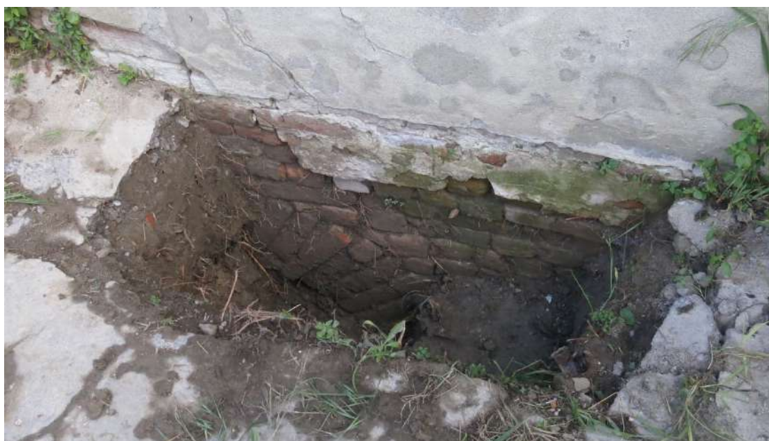
figura 21: fotografia dello scavo del saggio “sc Fon 2” eseguito nel 2024 all'esterno dell'edificio a ridosso della facciata sud-ovest che rivela un terreno argillo limoso al di sotto del marciapiede esistente e la fondazione ad arco
