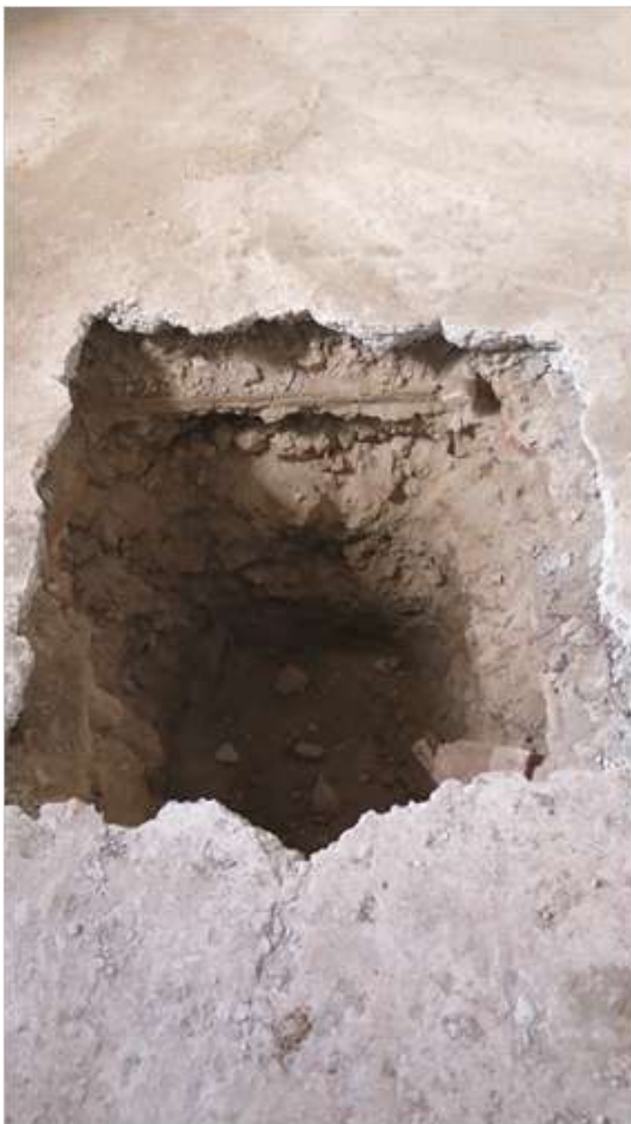
Figura 24_fotografia della seconda fase di scavo del saggio “sc Fon 1” eseguita nell’ambiente F che rivela l’assenza di vano ipogeo sottostante
