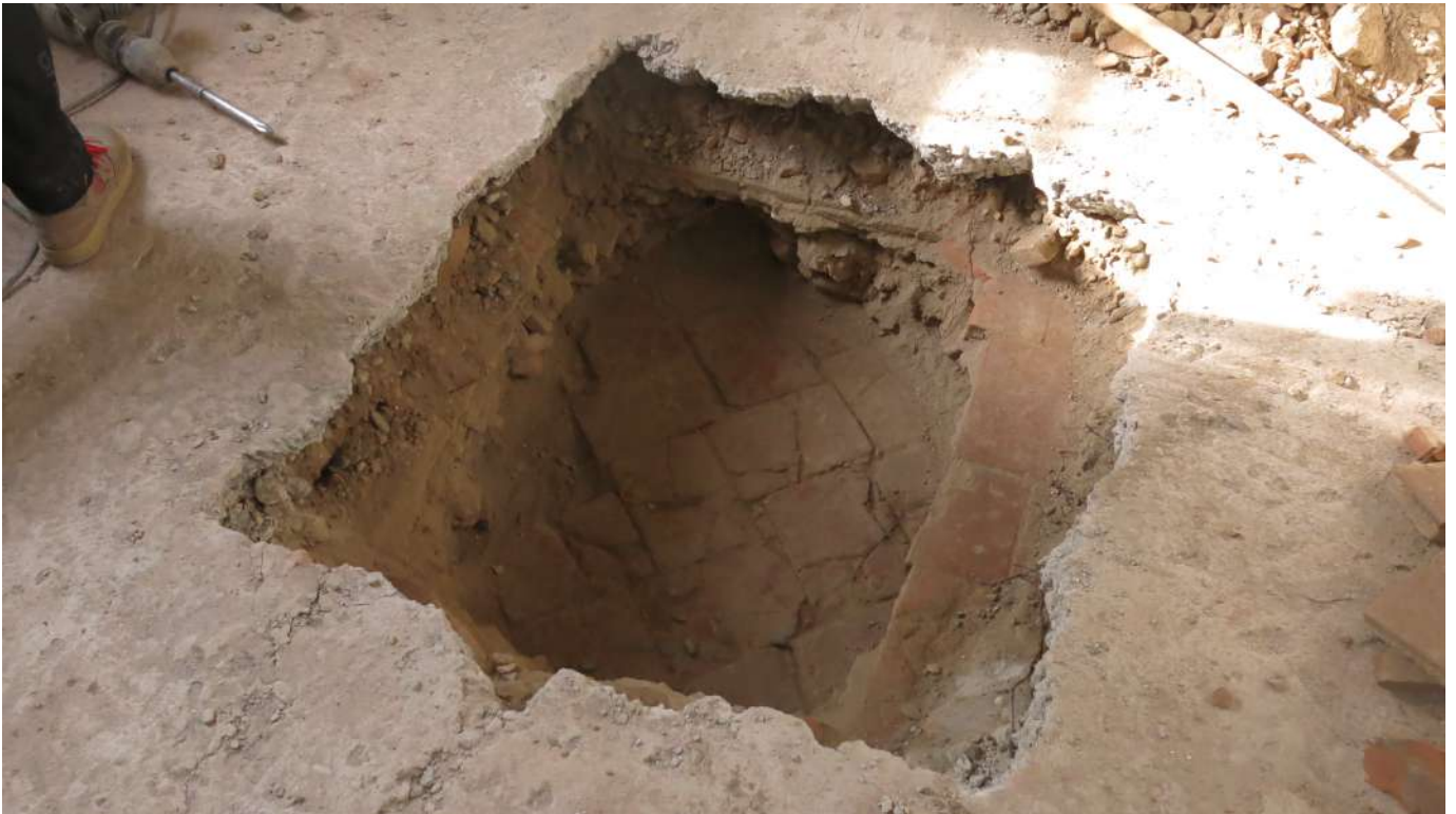
Figura 23_fotografia della prima fase di scavo del saggio “sc Fon 1” eseguita nell’ambiente F che rivela due livelli di pavimentazione laterizia. Il secondo livello è quello visibile in fondo allo scavo eseguito fino a 50 cm
