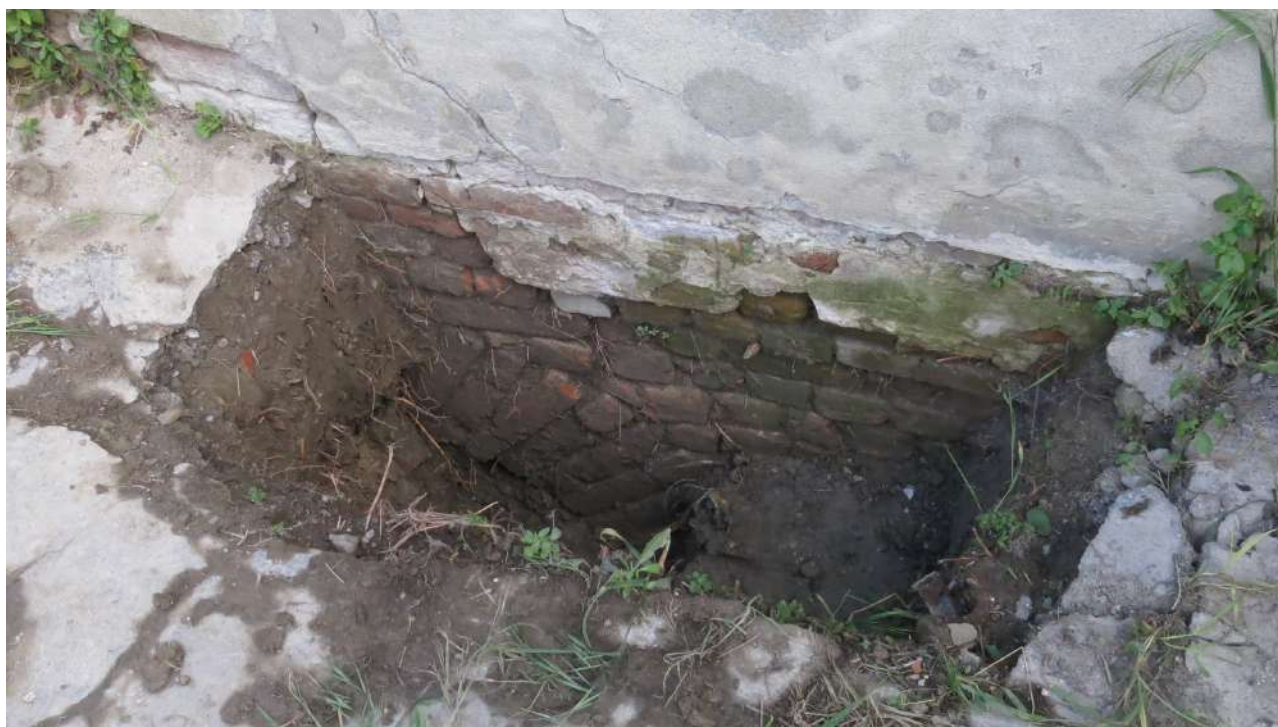
Figura 25_ fotografia dello scavo del saggio “sc Fon 2” eseguito all’esterno dell’edificio a ridosso della facciata sud-ovest che rivela un terreno argillo limoso al di sotto del marciapiede esistente e la fondazione ad arco
