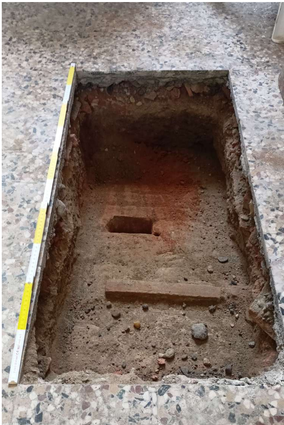
Figura 28_ fotografia dello scavo del saggio “sc Poz 2” eseguito nell’ambiente C che rivela una volta laterizia sotto la pavimentazione moderna esistente, vista prospettica.
