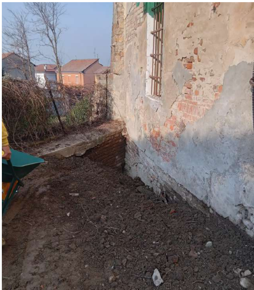
figura 22: fotografia dello scavo eseguito nel 2022/2023 all'esterno dell'edificio a ridosso della facciata sud-ovest dei locali 1 e 2 con presenza della fondazione ad arco
