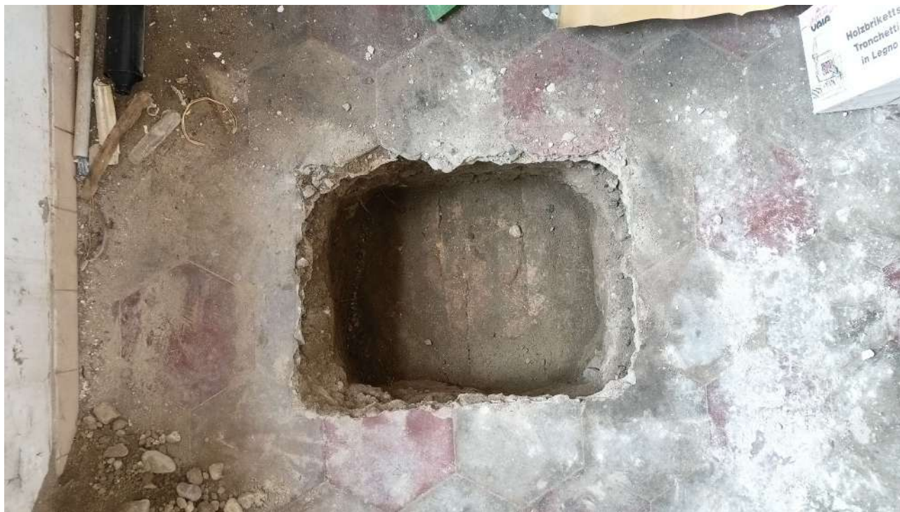
Figura 30_ fotografia dello scavo del saggio “sc Poz 3” eseguito nell’ambiente B che rivela una volta laterizia sotto la pavimentazione moderna esistente, vista zenitale.
