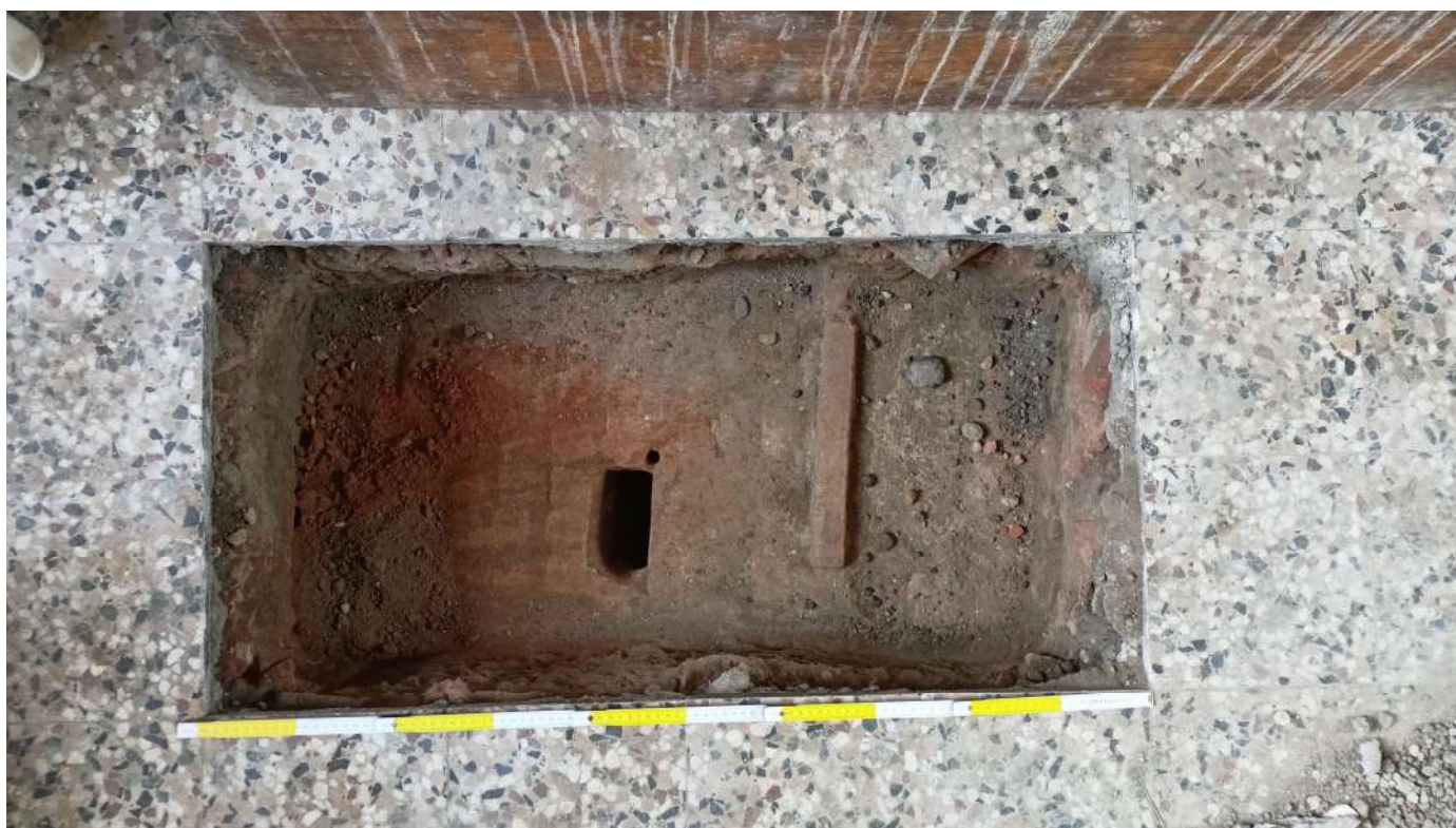
Figura 27_ fotografia dello scavo del saggio “sc Poz 2” eseguito nell’ambiente C che rivela una volta laterizia sotto la pavimentazione moderna esistente, vista zenitale.
