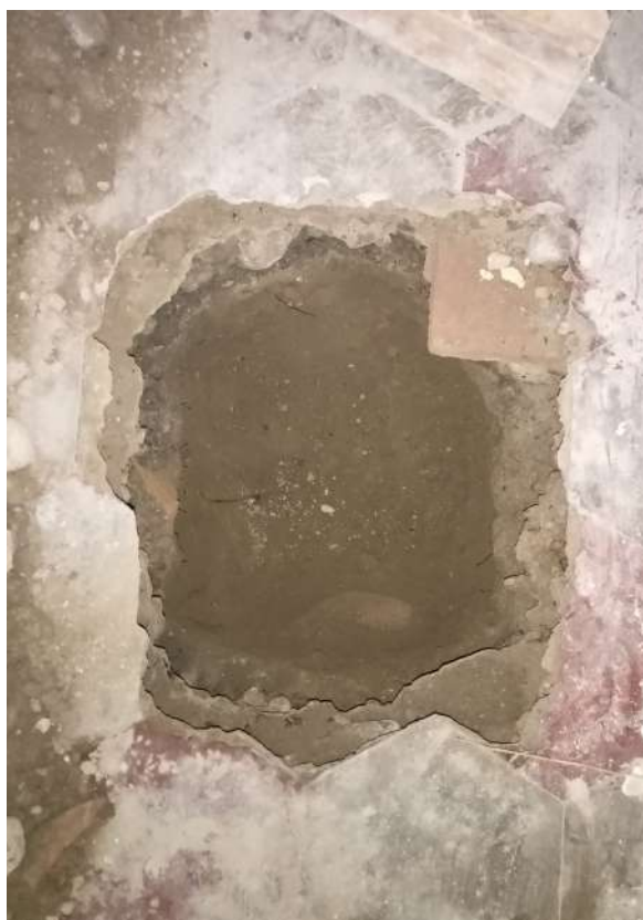
Figura 32_ fotografia dello scavo del saggio “sc Poz 5” eseguito nell’ambiente D che rivela uno strato di preparazione sotto la pavimentazione moderna esistente, vista zenitale.
