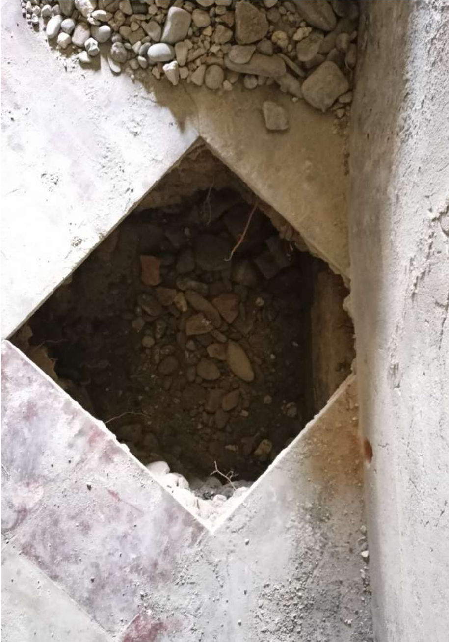
Figura 33_ fotografia dello scavo del saggio “sc Poz 6” eseguito nell’ambiente E che rivela uno strato di preparazione sotto la pavimentazione moderna esistente, vista zenitale.
