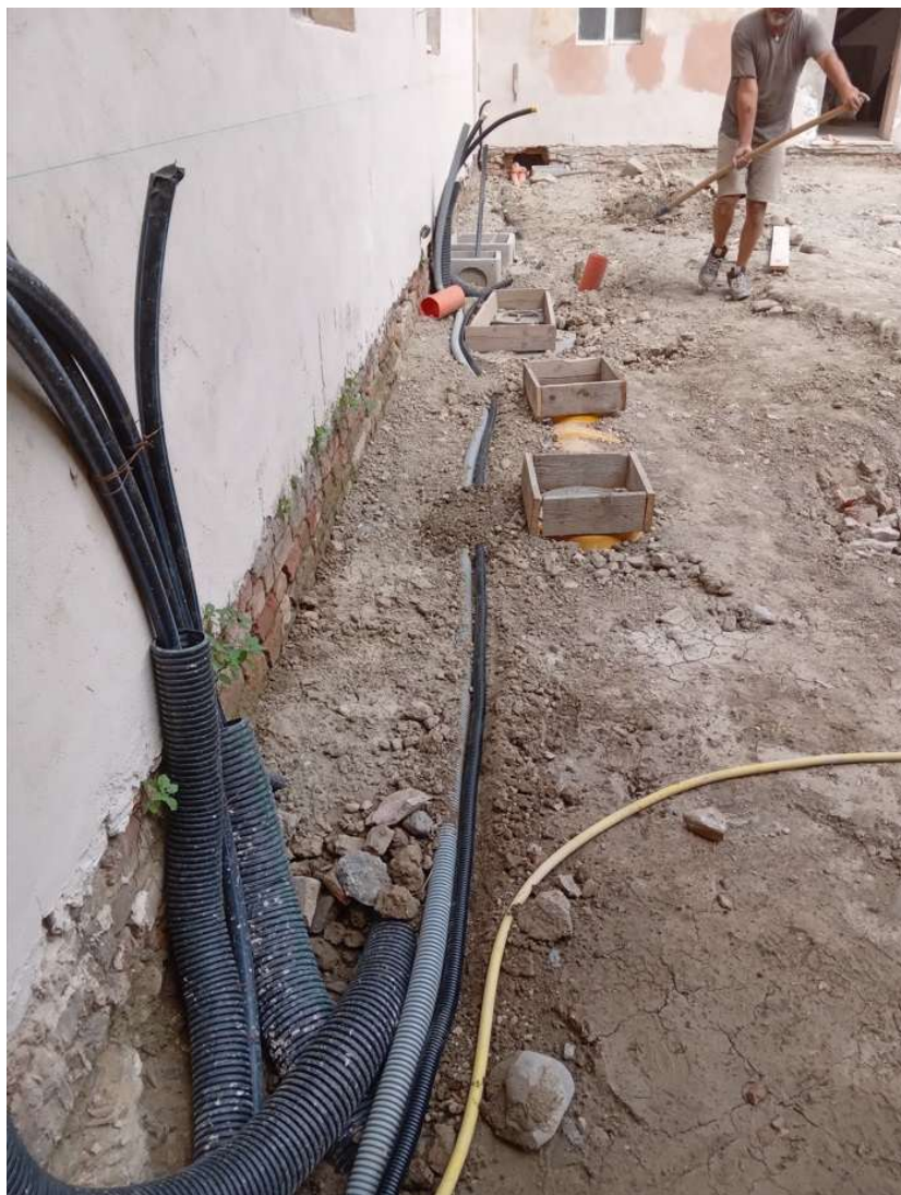
figura 21: vista delle reti interrate esistenti già realizzate nel cortile del Castello (evidenziate con dei casseri in legno sono le ispezioni delle fosse biologiche di fronte della finestra locale B)
