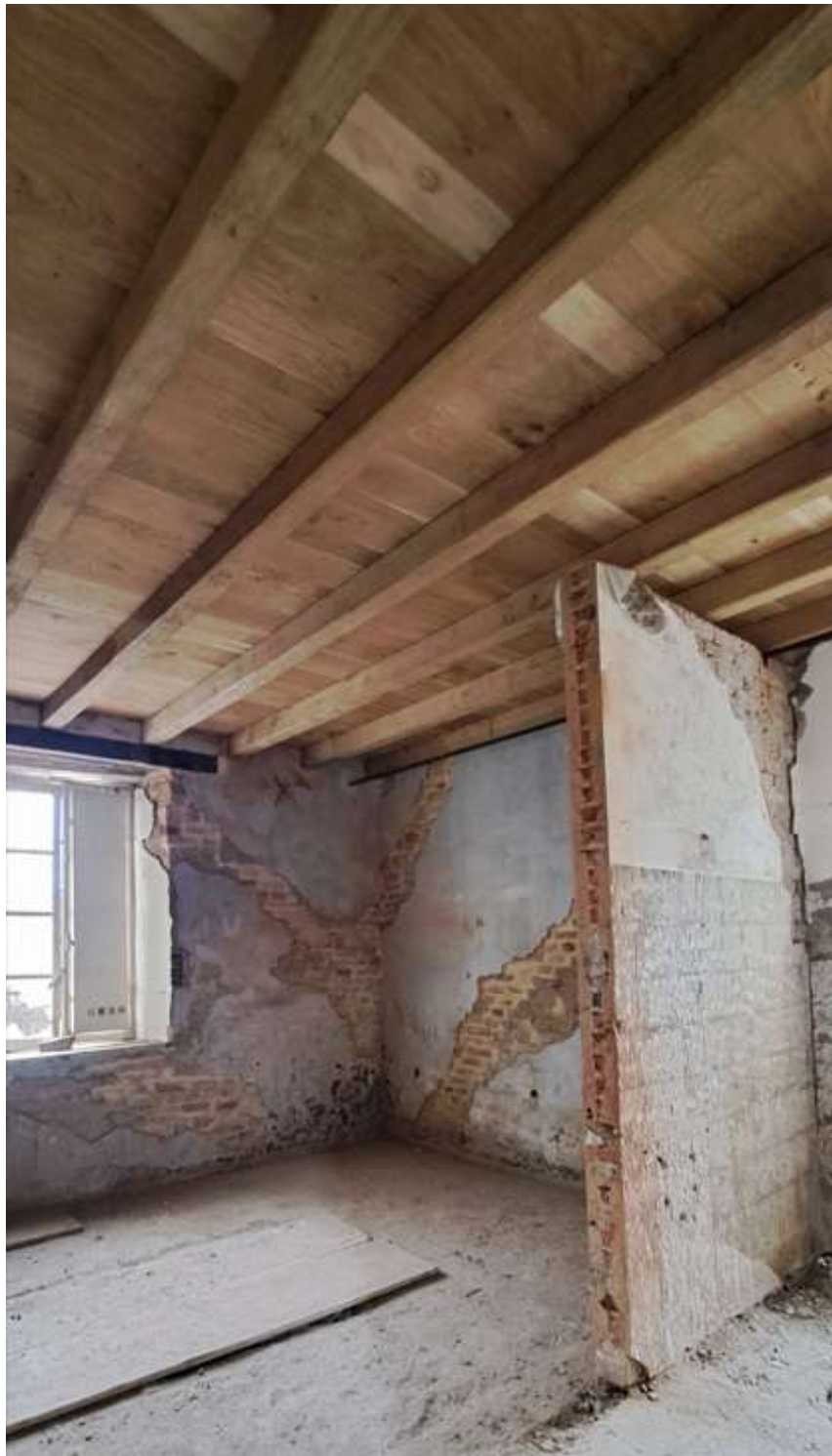
figura 5: fotografia del locale F con soletta restaurata ed interventi di cuciture armate/cuci scuci già eseguite
