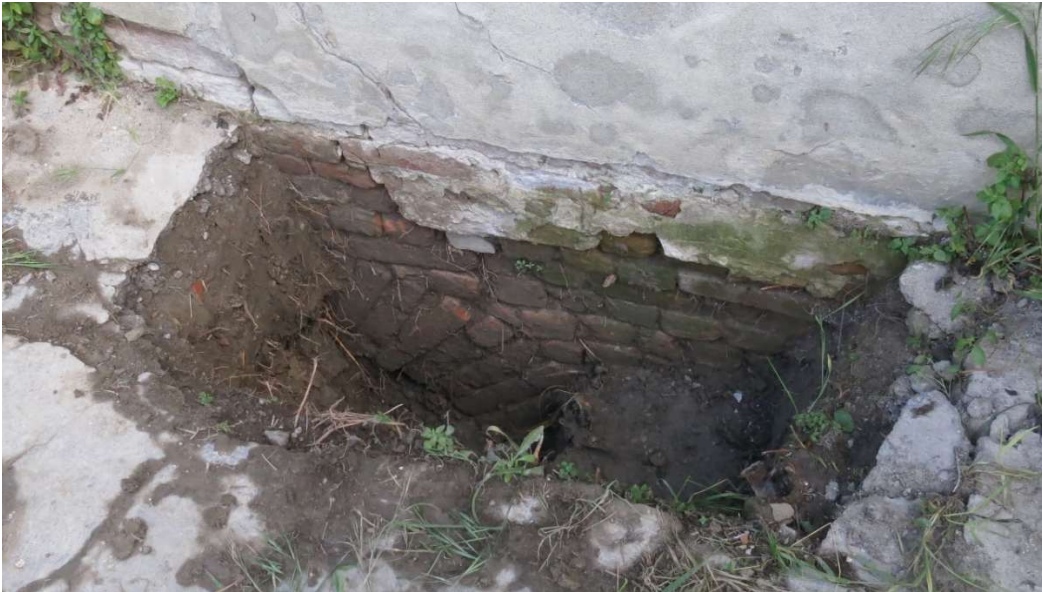
figura 3: fotografia dello scavo del saggio “sc Fon 2” eseguito nel 2024 all'esterno dell'edificio a ridosso della facciata sud-ovest che rivela un terreno argillo-limoso al di sotto del marciapiede esistente e la fondazione ad arco
