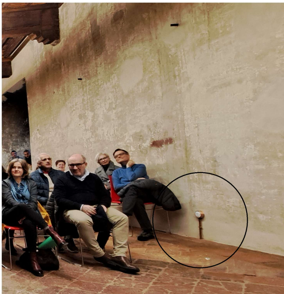
figura 19: tipologia di impianti elettrici a vista in rame già esistenti all'interno del Castello
