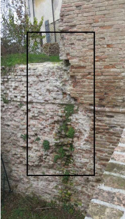
figura 11: degrado sulle pareti del fossato connesso ad una imperfetta gestione delle acque meteoriche. Si notino le efflorescenze e la vegetazione sulla parete storica.
