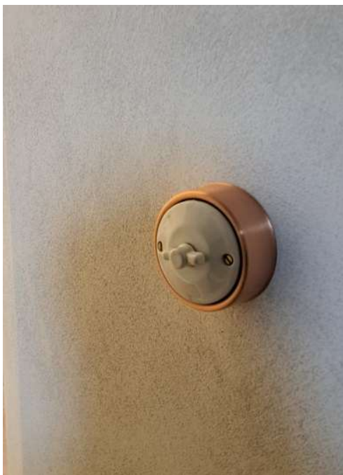
figura 20: tipologia di impianti elettrici a vista in rame già esistenti all'interno del Castello
