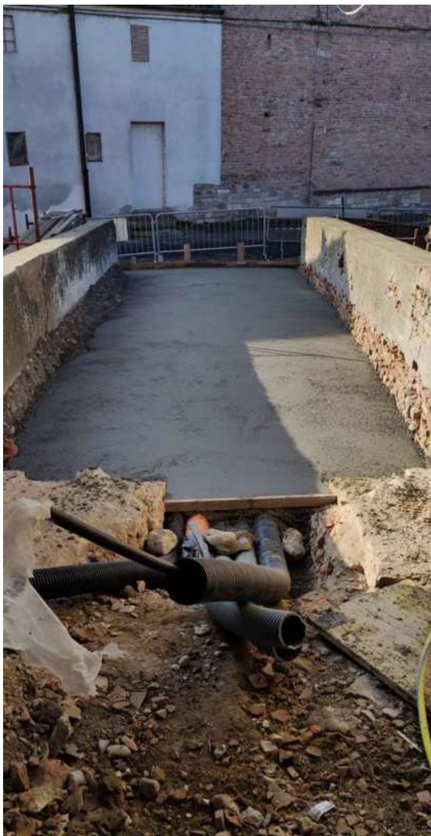
figura 30: vista delle reti interrate esistenti già realizzate nell'androne di ingresso del Castello
