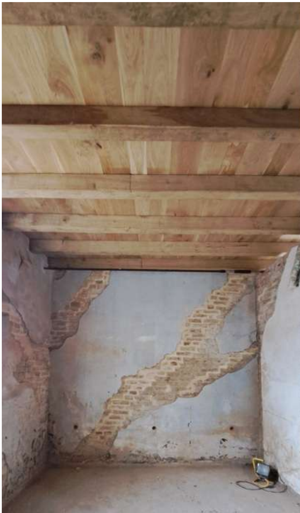
figura 6: fotografia del locale F con soletta restaurata ed interventi di cuciture armate/cuci scuci già eseguite
