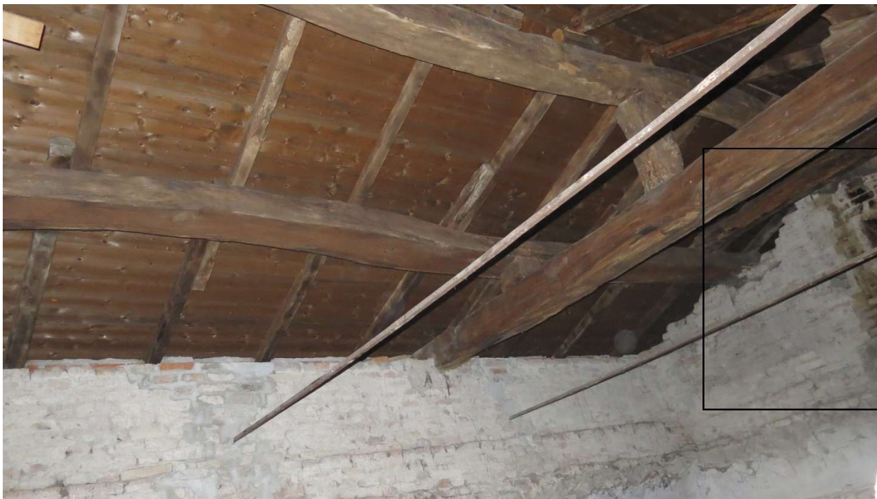
figura 32: Canna fumaria esistente presente nel sottotetto (lato sinistro delle foto)
