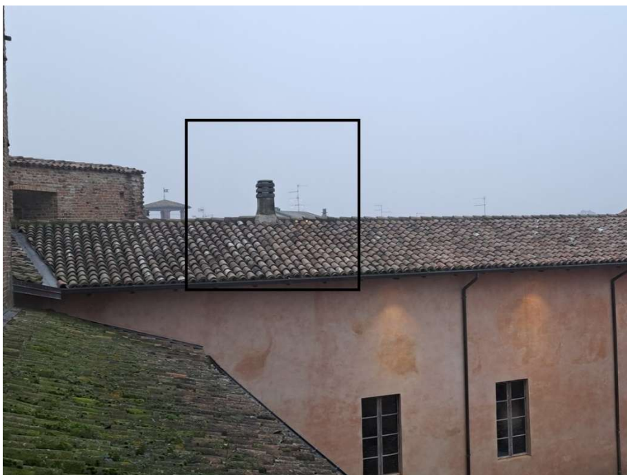
figura 33: Canna fumaria esistente in copertura presente nel sottotetto vista dall'esterno
