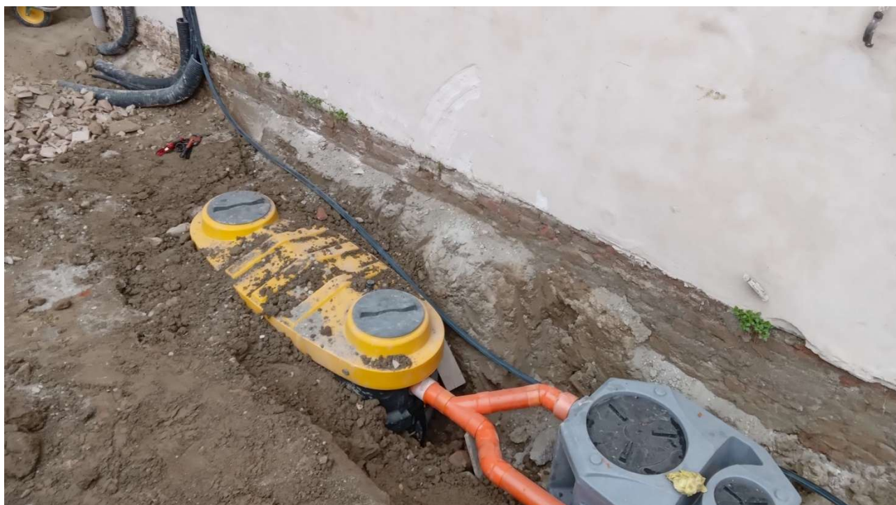
figura 28: vista delle reti interrate esistenti già realizzate nel cortile del Castello (fossa biologica ed altri impianti di fronte della finestra locale B).
