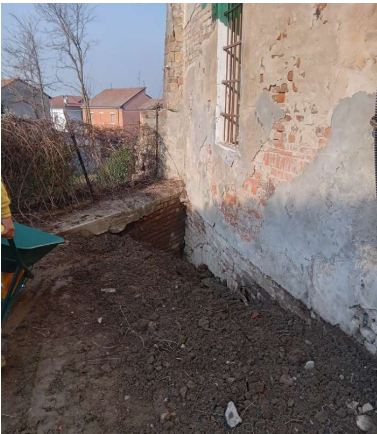
figura 4: fotografia dello scavo eseguito nel 2022/2023 all'esterno dell'edificio a ridosso della facciata sud-ovest dei locali 1 e 2 con presenza della fondazione ad arco
