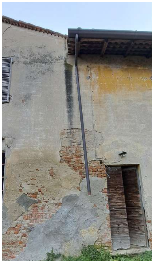
figura 10: degrado su intonaci connesso al mancata gestione delle acque meteoriche e correntini a vista
