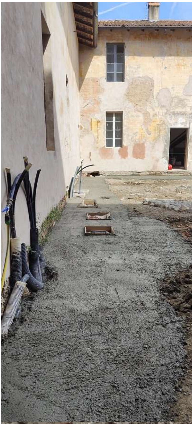
figura 26: vista delle reti interrate esistenti già realizzate nel cortile del Castello (fossa biologica ed altri impianti di fronte della finestra locale B – dopo posa di massetto di protezione)
