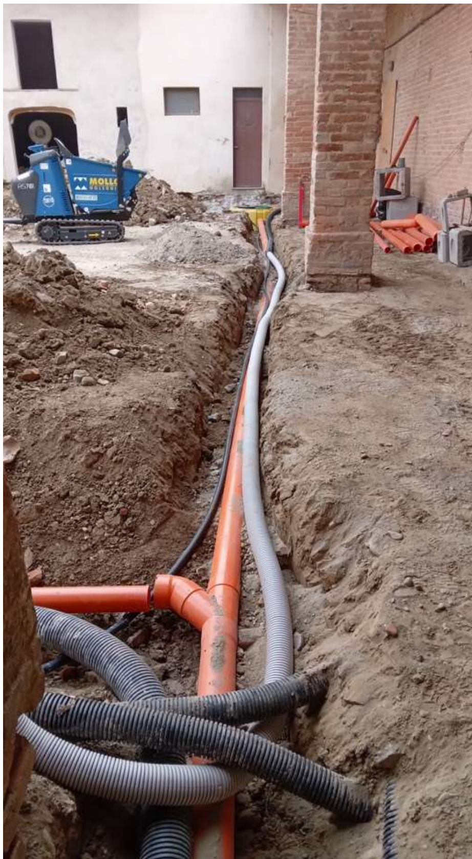
figura 23: vista delle reti interrate esistenti già realizzate nel cortile del Castello (angolo tra locale B e cortile del Castello)
