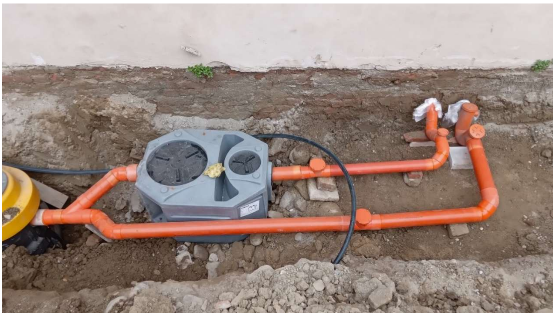
figura 24: vista delle reti interrante esistenti già realizzate nel cortile del Castello (fossa biologica ed altri impianti di fronte della finestra locale B). E' presente anche una predisposizione di scarico ulteriore.
