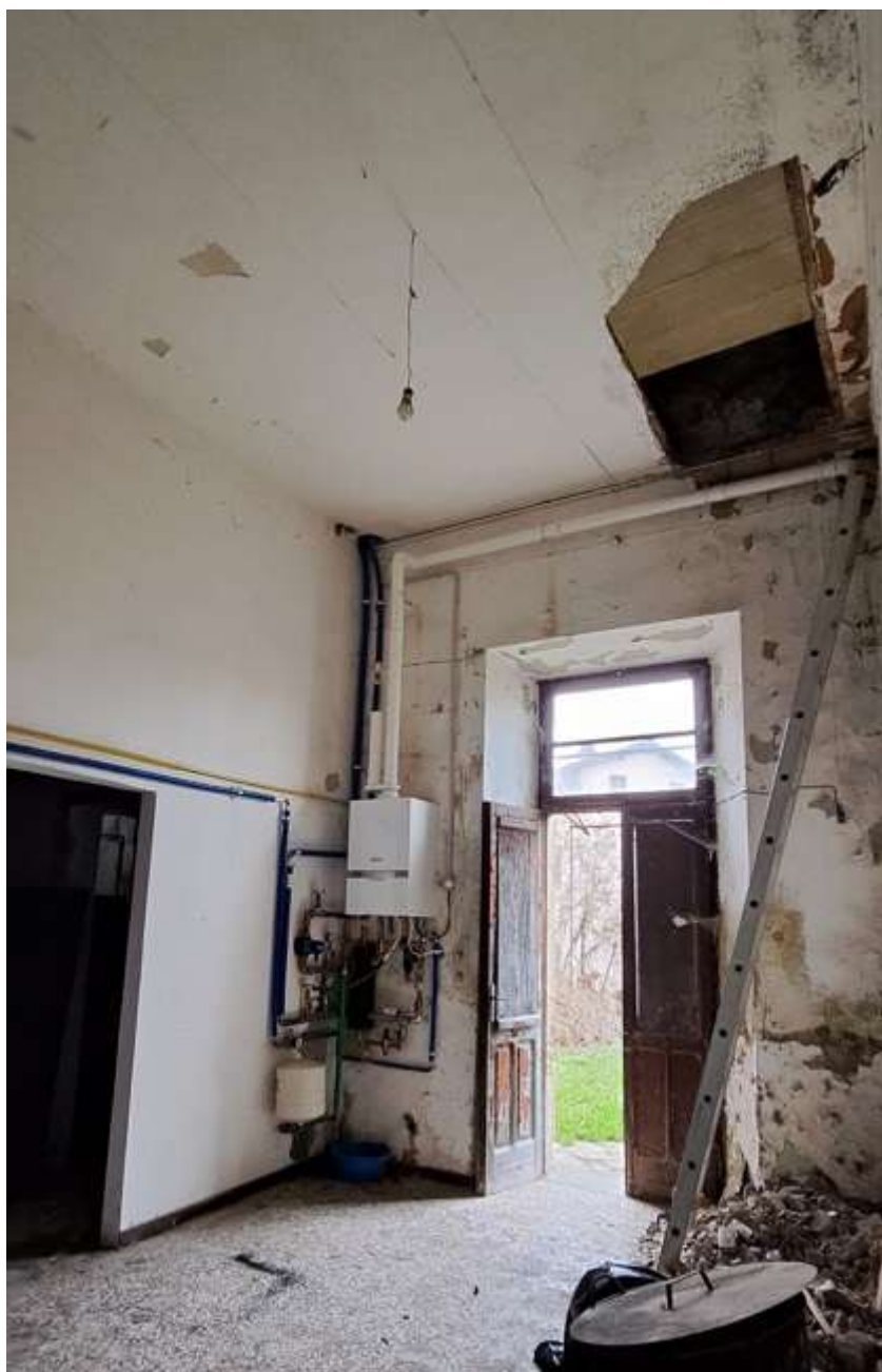
figura 31: caldaia esistente locale C da ricollocare nel sottotetto
