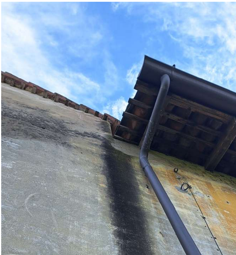
figura 12: degrado su intonaci connesso al mancata gestione delle acque meteoriche e correntini a vista
