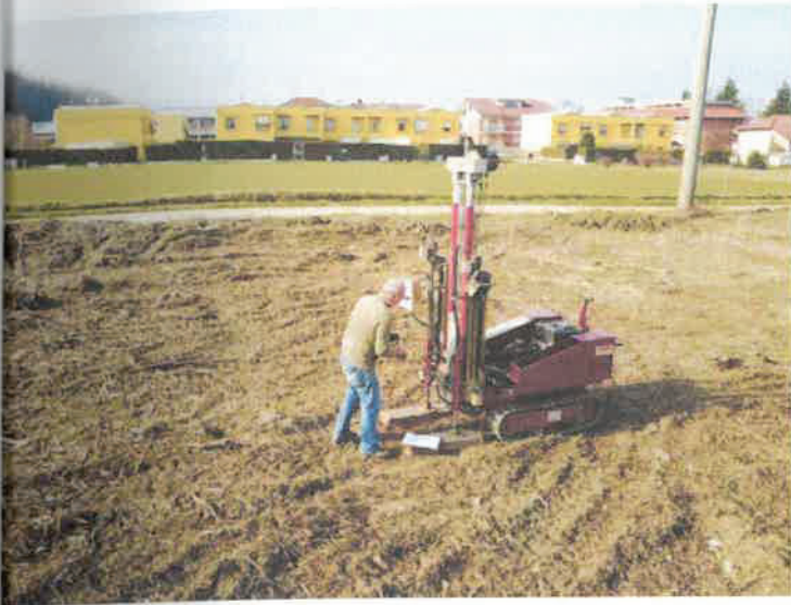
Penetrometro dinamico/statico superpesante PAGANI TG63-100 posizionato sul foro P2.
